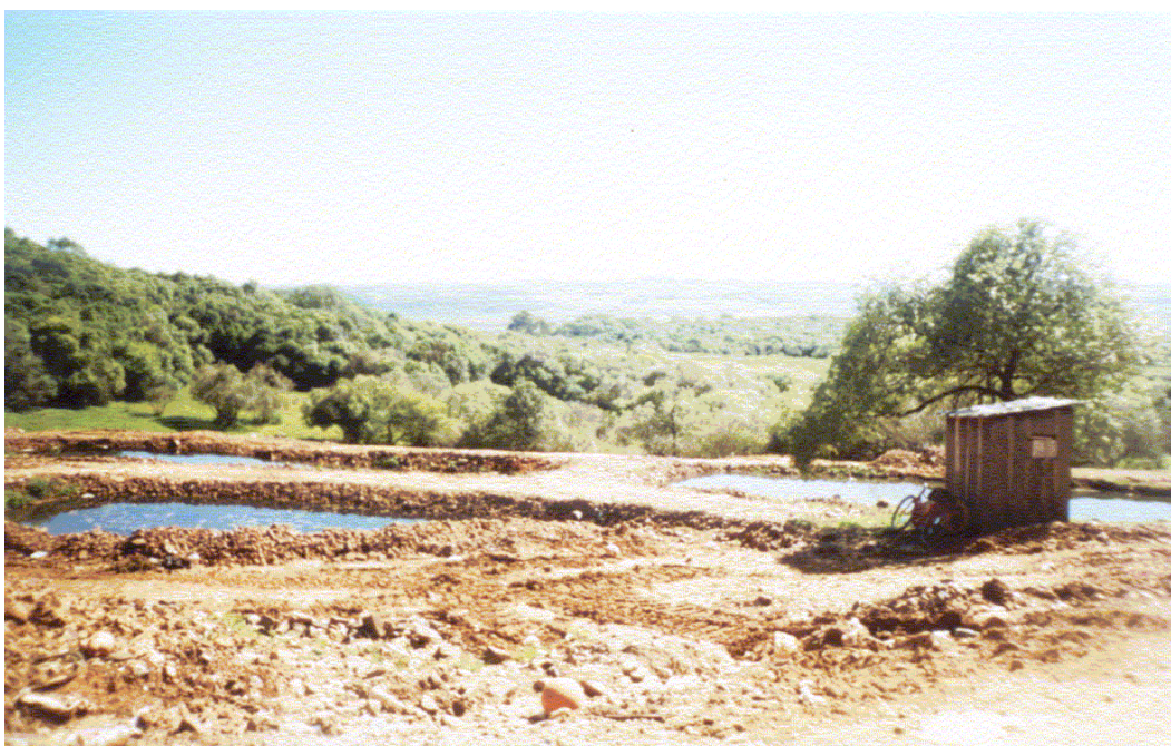
FIGURA 22: Bacias de decantação do atual "aterro sanitário" de Sant'Ana do Livramento - RS. Data: 09/2002.
