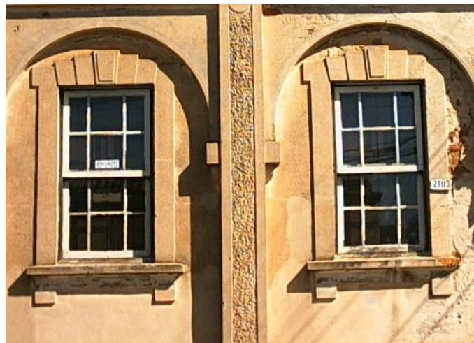
Figura 24 – Conjunto de janelas do tipo guilhotina, com os trabalhos em argamassa ao redor (ACERVO DO AUTOR, 2005).
