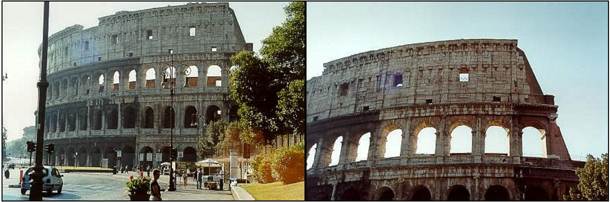
Figuras 3 e 4 – As duas vistas do Coliseu exibem, na finalização das arcadas, os reforços executados em mármore e tijolos para consolidar a ruína (EURO28.JPG; EURO29.JPG).
