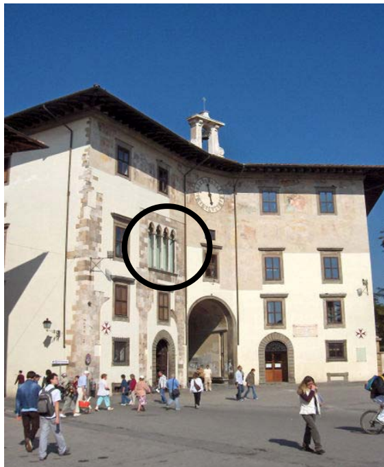
Figura 13 – No Palazzo dell Orologio, em Pisa, o terceiro nível de esquadrias exibe uma janela gótica, que destoa da unidade potencial do edifício, clássico (450PX-PISA. PALAZZO_DELL_OROLOGIO.JPG).
