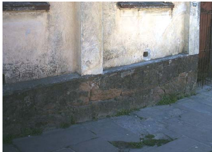
Figura 23 – Soco de edificação, exibindo uma gateira (ACERVO DO AUTOR, 2005).
