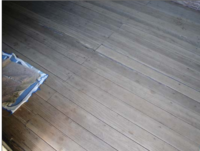
Figura 26 – Piso tabuado: assoalho (ACERVO DO AUTOR, 2007).
