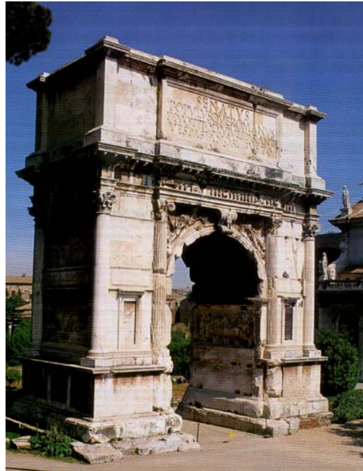
Figura 5 – Vista atual do Arco de Tito, mostrando as reintegrações executadas por Raffaele Stern e Giuseppe Valadier, a partir de 1819, com o cuidado tomado para não ocorrer a falsificação com os elementos adicionados (ARCO-TITO1.JPG).
