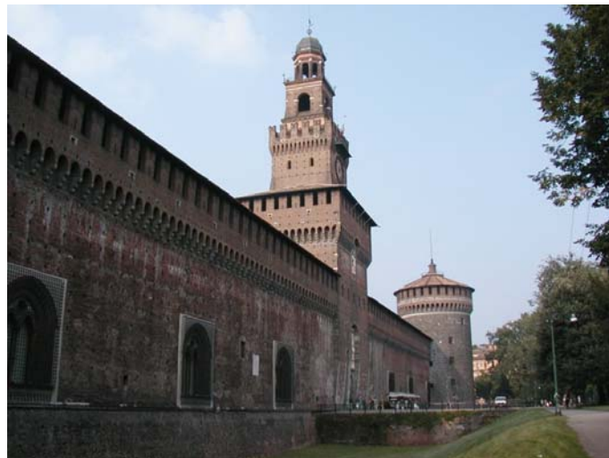
Figura 8 – Foto atual da torre do Filarete, no Castelo Sforzesco, em Milão. A torre foi reconstruída com projeto de Luca Beltrami, baseado em alguns quadros que haviam sido pintados, anteriores a sua queda (CASTELLO_SFORZESCO1024X768.JPG).
