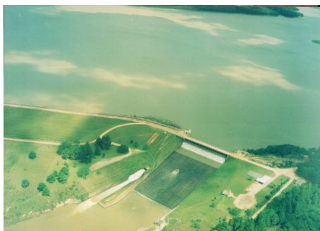
Figura 2.11 - Barragem do Arroio Duro. Fonte: www.aud.org.br , 2007.
