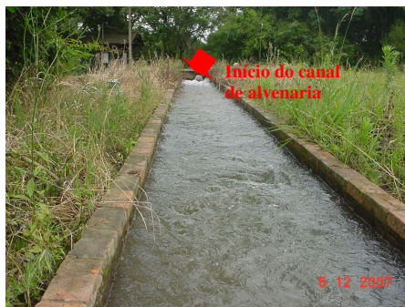
Figura 4.2 - Canal principal de alvenaria. Fonte: Acervo GERHI.
