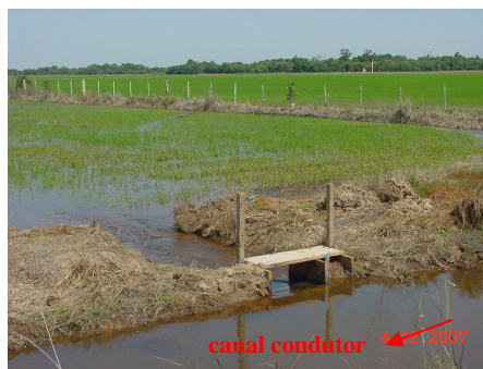
Figura 3.10 - Vertedor retangular de madeira Fonte: Acervo GERHI.
