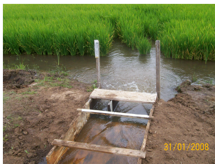
Figura 4.3 - Canal principal de alvenaria. Fonte: Acervo GERHI.
