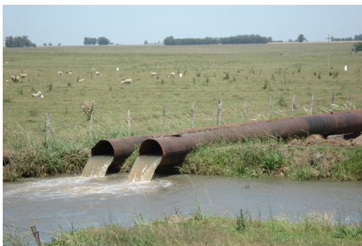
Figura 13 - Final da canalização. Fonte: Acervo GERHI.
