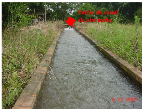
Figura 3.7 - Canal principal de alvenaria. Fonte: Acervo GERHI.
