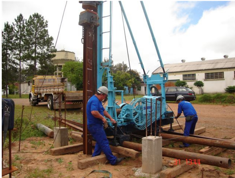
Fig. 4.9 – Preparo do equipamento para início da cravação
