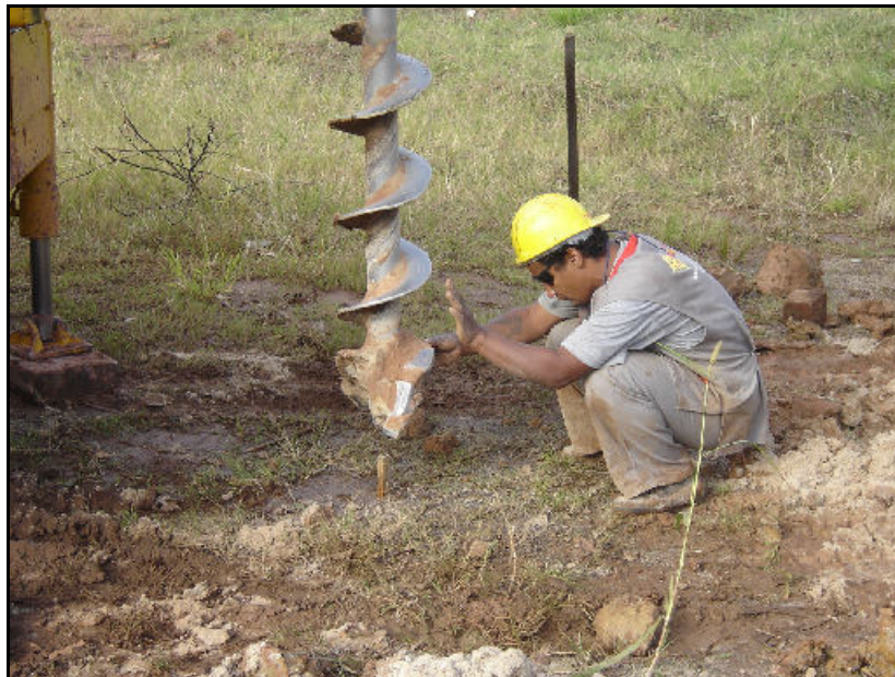
Fig. 4.4 – Trado para a escavação das estacas de reação
