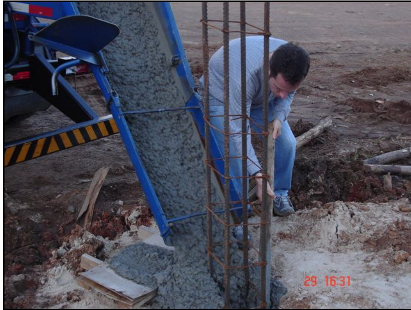
Fig. 4.7 – Concretagem da estaca de reação
