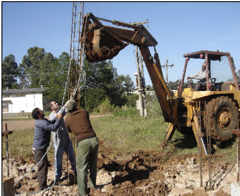
Fig. 4.6 – Colocação da armadura das estacas de reação
