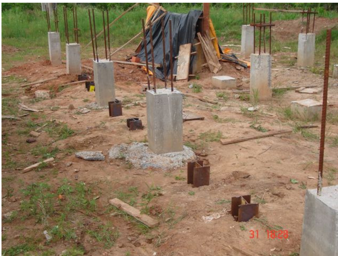
Fig. 4.1 – Disposição das estacas no campo experimental
