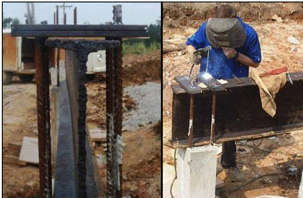
Fig. 4.8 – Viga de reação
