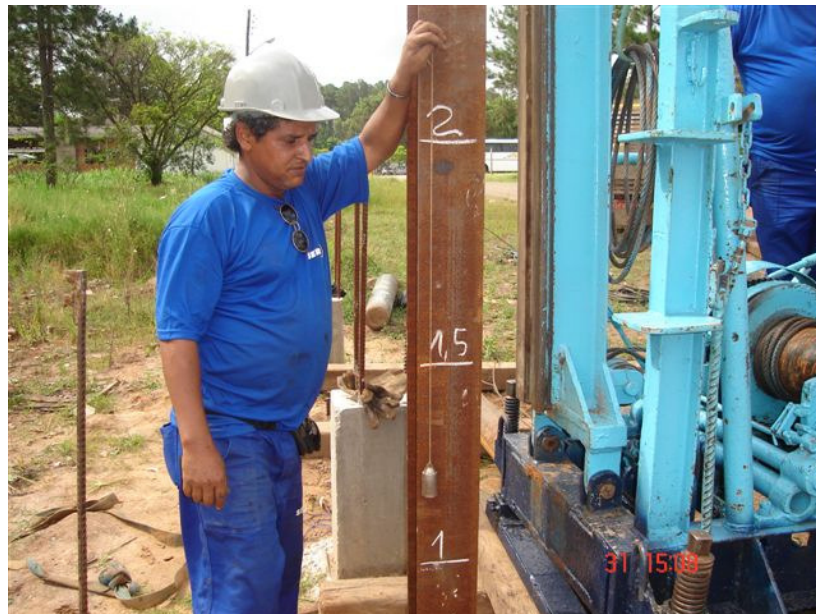
Fig. 4.10 – Verificação do prumo da estaca
