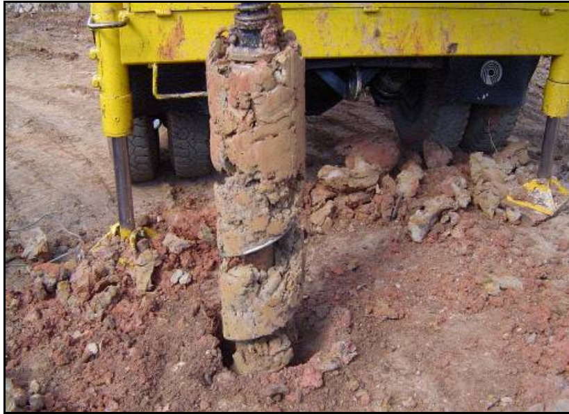
Fig. 4.5 – Escavação da estaca de reação
