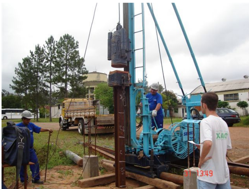
Fig 4.11 - Cravação do perfil metálico com execução do diagrama de cravação
