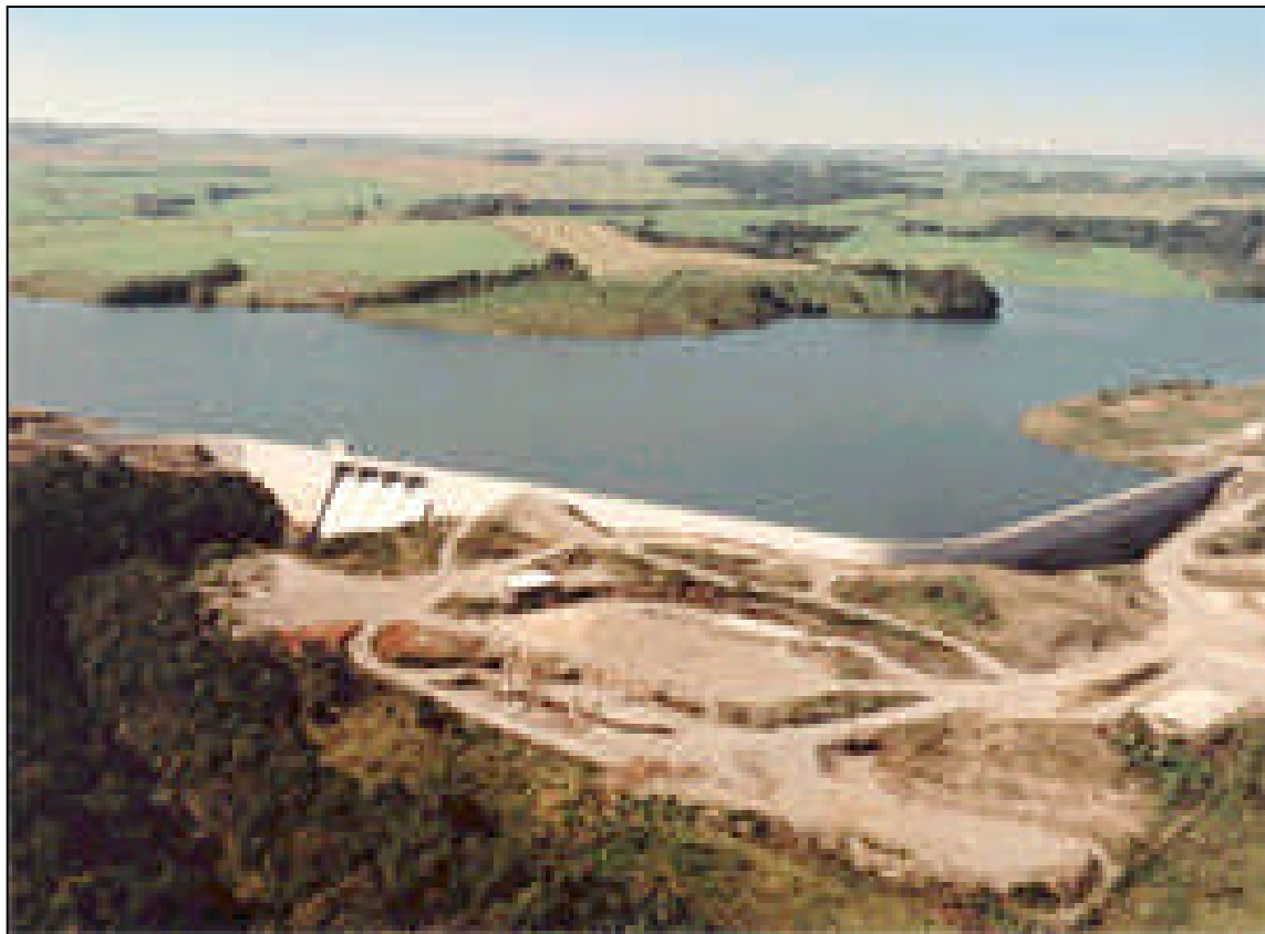
Figura 2 – Vista Geral da Barragem Rodolfo da Costa e Silva.
