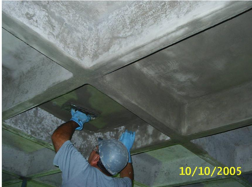
**Figura 12 – Laje nervurada recebendo acabamento superficial.**
