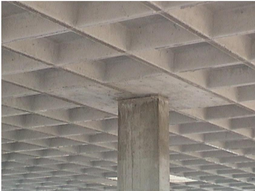
**Figura 10 – Laje lisa nervurada apoiada diretamente sobre pilares (visualização inferior).**
