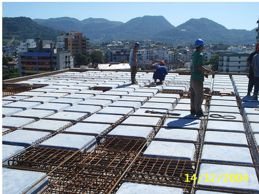
**Figura 13 – Laje lisa nervurada apoiada diretamente sobre pilares (visualização superior).**
