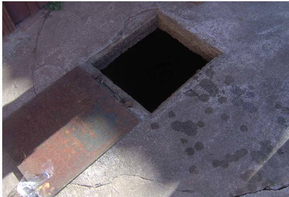
Figura 8 - Poço escavado no nível do terreno sem vedação adequada apresentando risco potencial de contaminação, Santa Maria (2008).
