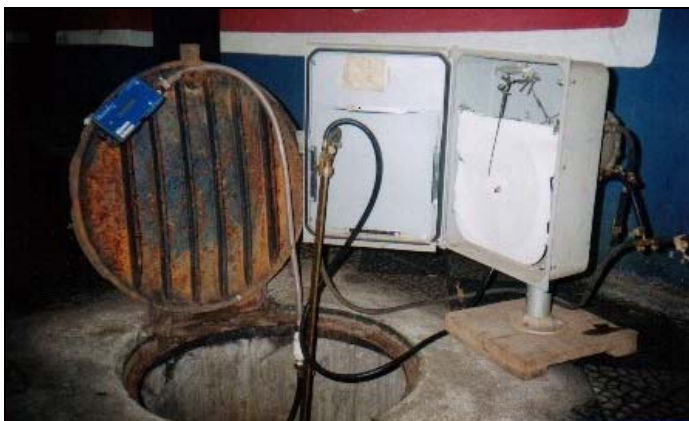
Figura 4.7 – EP11 e macromedidor na entrada do setor.
