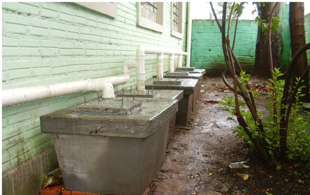
Figura 3.3 – Amostrador que coleta água da chuva do telhado da Escola Vicente Farençena.
