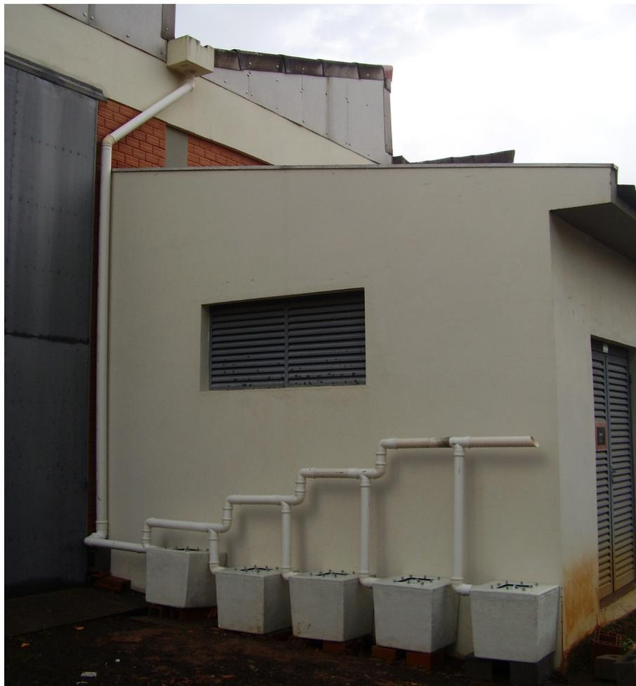
Figura 3.4 – Amostrador montado no Campus da UFSM.
