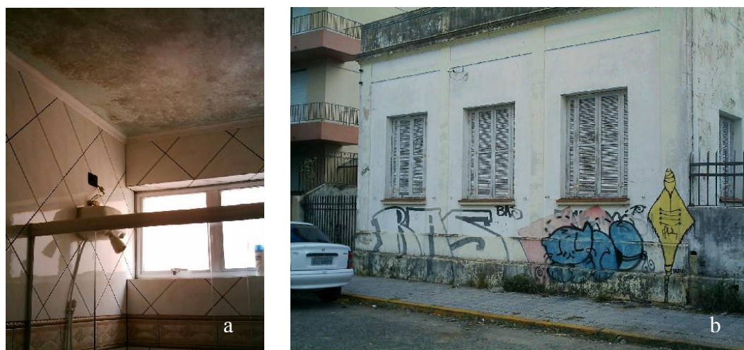
Figura 19 – Desenvolvimento de microrganismos em pintura interna (a) e externa (b).(foto : Flayane H. Silva)
