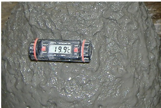
Figura 20: Controle de temperatura do concreto.
