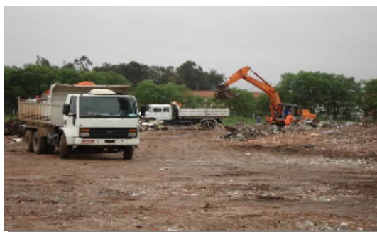
Figura 8 – Transporte sendo feito com a utilização de caminhão-caçamba. Maio/2007
