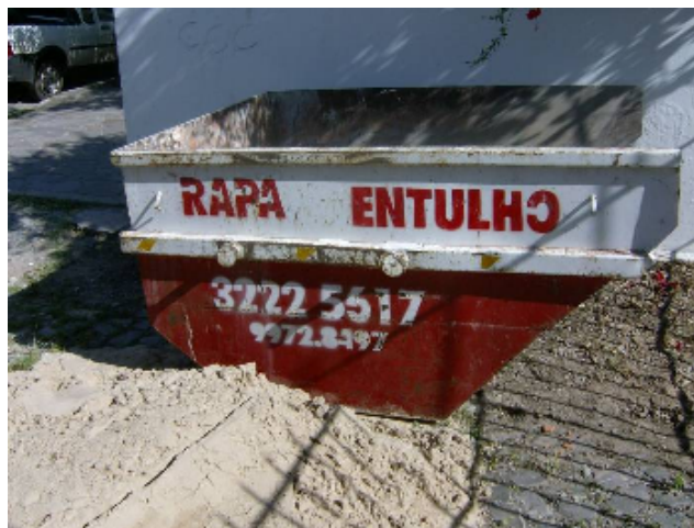
Figura 17 – Ausência de identificação volumétrica e cobertura. Junho/2008
