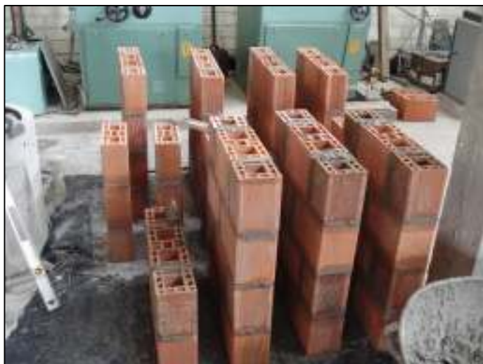
Figura 22 – Execução de pequenas paredes
