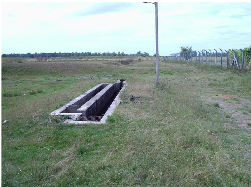
Figura 4 - Gradeamento, caixa de areia, e calha Parshal
