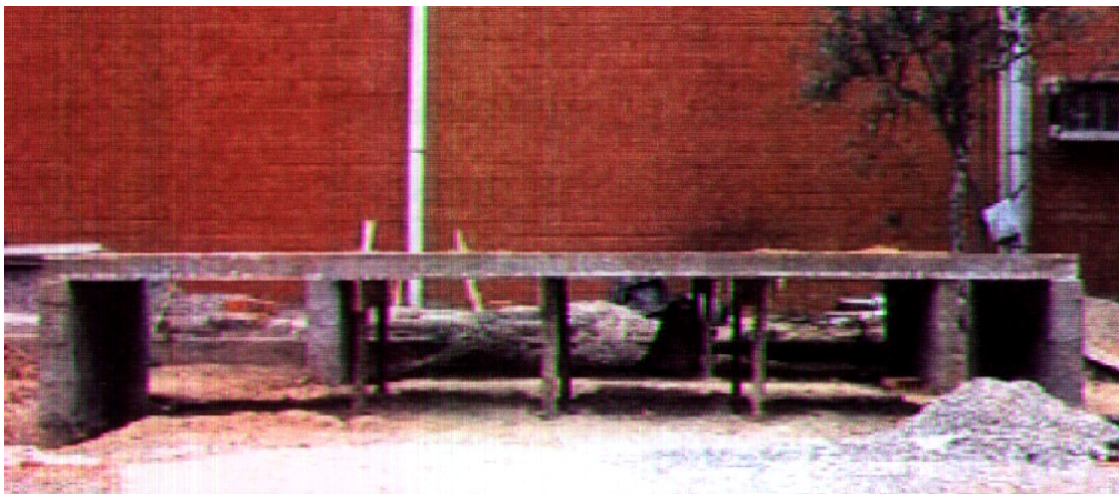
FIGURA 12 – Laje pré-moldada treliçada com escoramentos e formas
