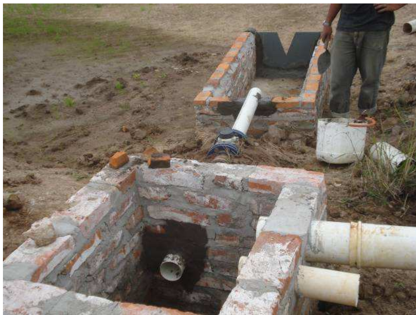
Figura 24 - Sistema - Hidrômetro x Vertedor na área de plantio convencional.
