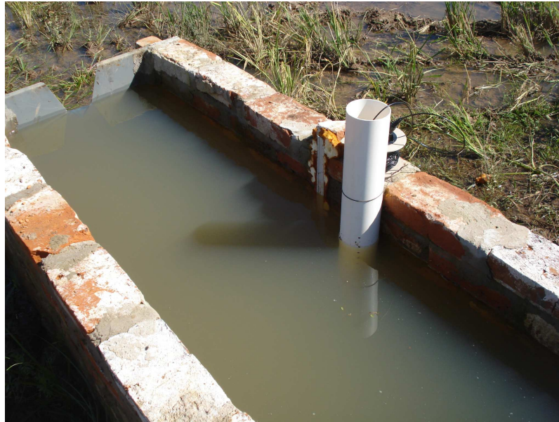
Figura 27 - Instalação do sensor de nível.
