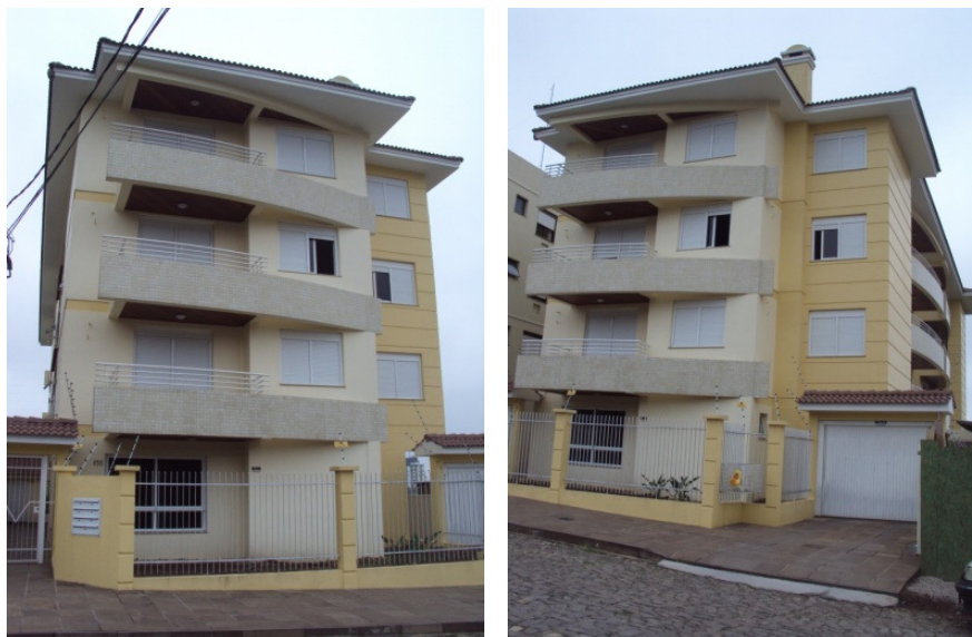
Figura 10 - Vistas frontais, de ângulos diferentes do edifício residencial A.
