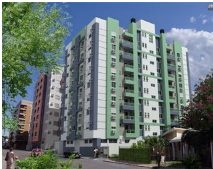
Figura 14 - Vista do edifício residencial C (edifício primeiro plano).
