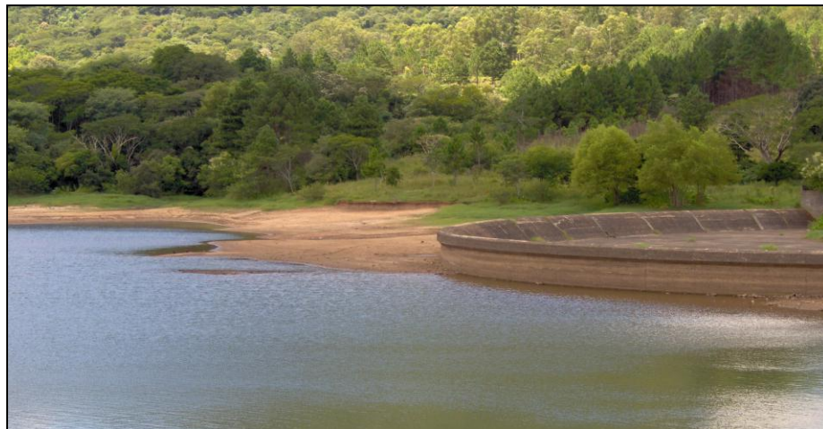
Figura 8: Aspecto do nível da água no vertedouro do reservatório, em 10/Fev/2011.
