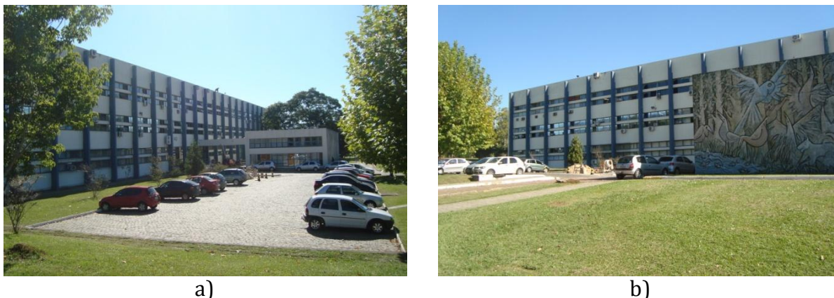
Figura 3.1 - Vista externa do edifício do CAL da UFSM.
