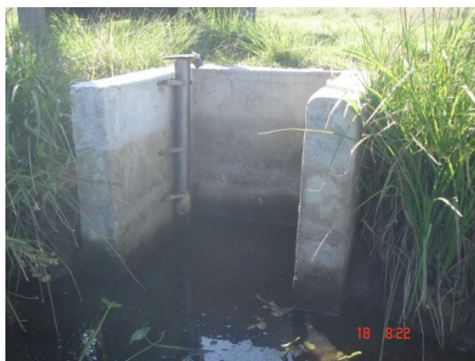
Figura 3.11 - Poço tranquilizador com suporte para o sensor
