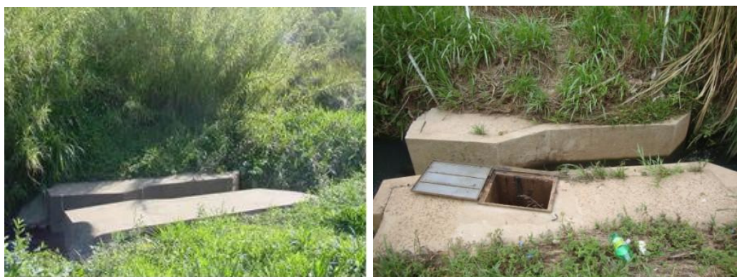
Figura 3.8 - Calha Parshall da MU
