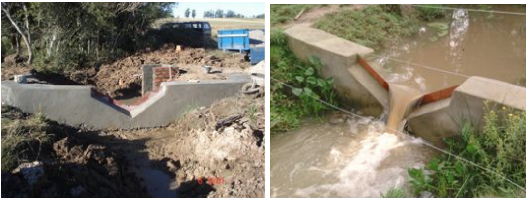
Figura 4.6 - Vertedor triangular da MR.
