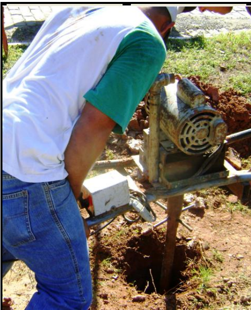
Figura 3.14 – Execução das estacas de compressão com o trado mecânico
