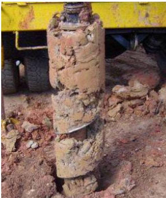
Figura 3.6 – Execução das estacas de reação com perfuratriz do tipo rotativa
