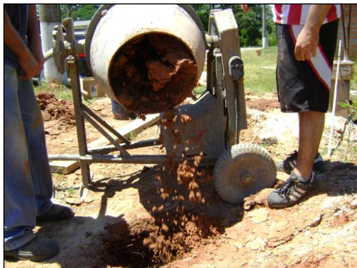
Figura 3.16 – Preparação das estacas de compressão
