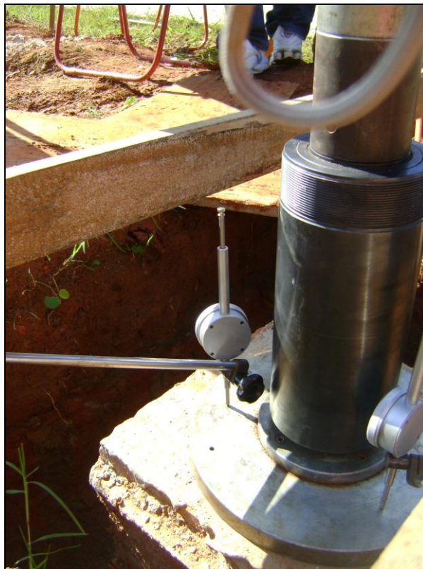
Figura 3.20 – Placa sobre o bloco e o macaco hidráulico
