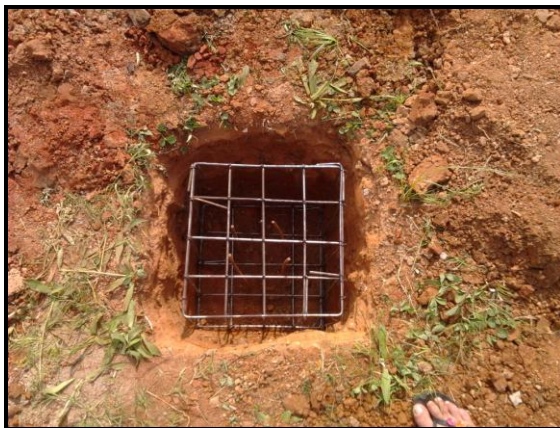
Figura 3.18 Detalhe da armadura do bloco
