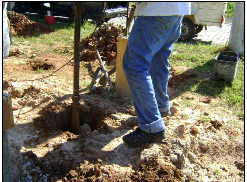
Figura 3.15 – Execução das estacas de compressão com o trado mecânico
