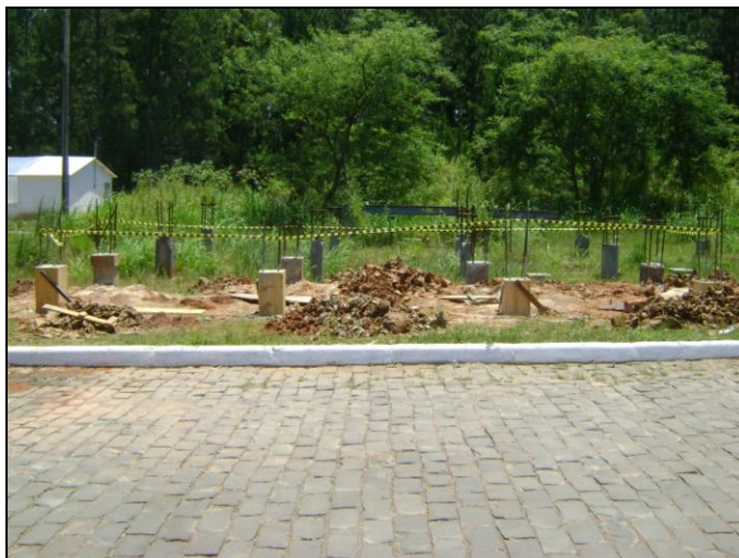
Figura 4.4 – Campo Experimental de Engenharia Geotécnica da UFSM
