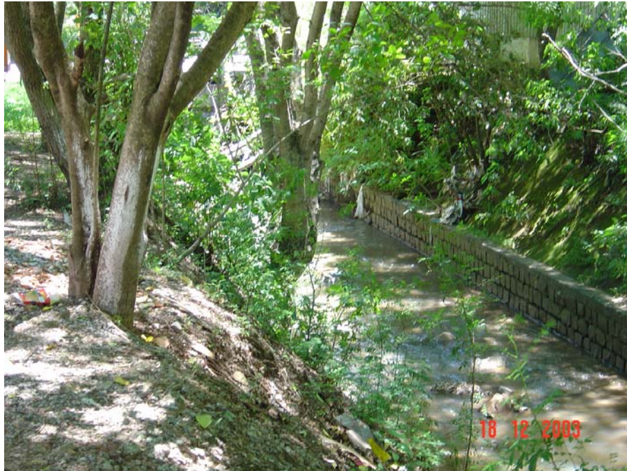
FIGURA 15. Ponto de amostragem P-A – Drenagem do Setor 1.
