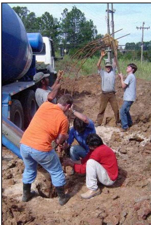
Figura 3. 5 - Coloca o da armadura de rea o
