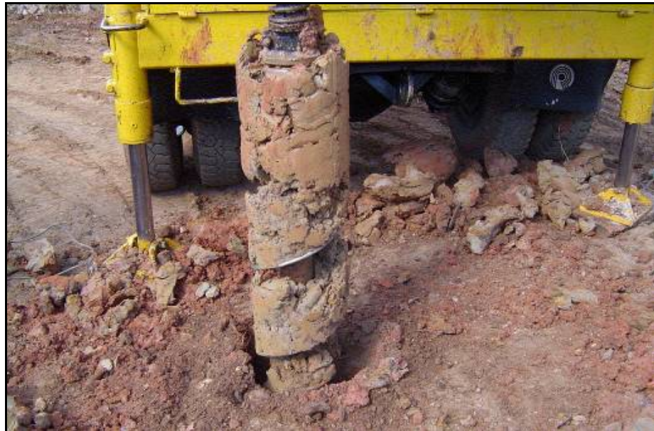
Figura 3. 3 - Execu o da estaca de rea o com o caminh o perfuratriz
