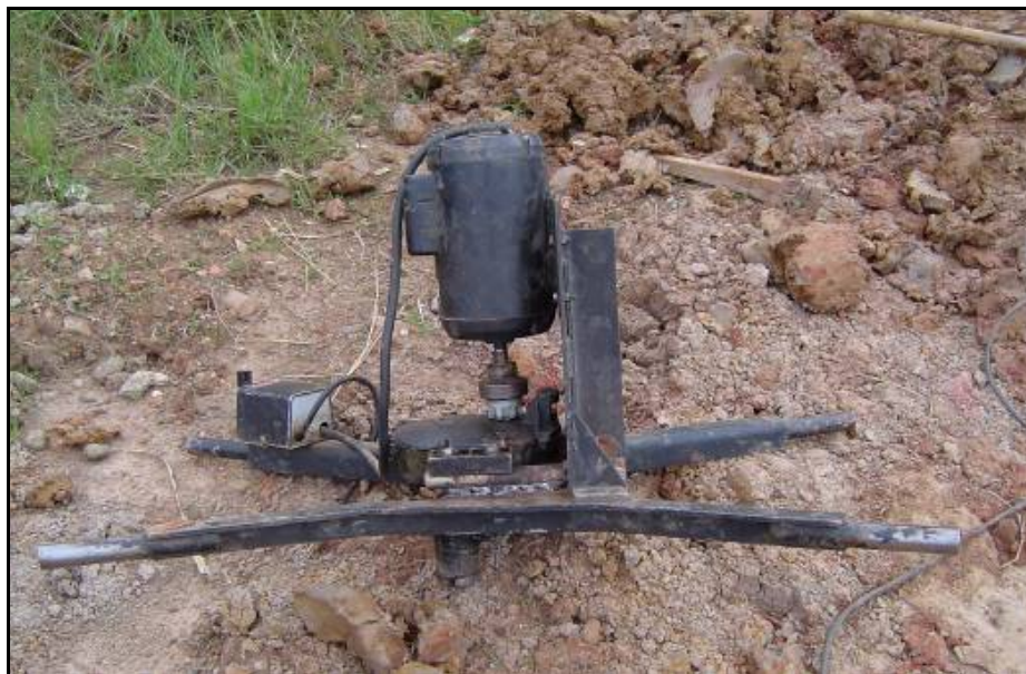
Figura 3. 4 - Equipamento utilizado para execu o das estacas de compress o
