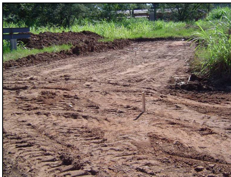
Figura 4. 1 - Vista da área do CEEG/UFSM
