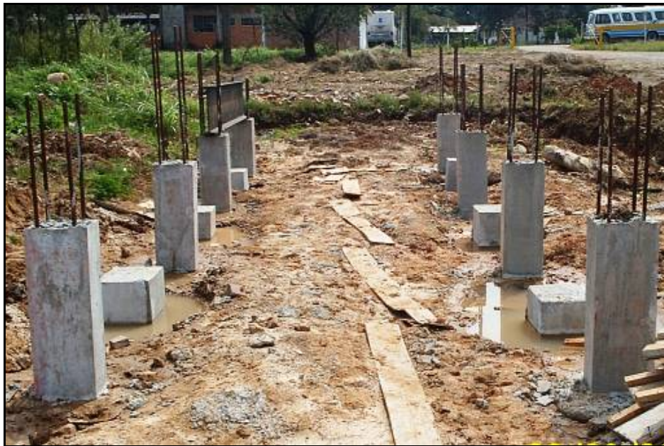
Figura 3. 6 - Blocos de coroamento e pilares desformados
