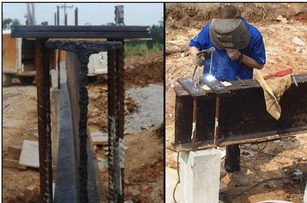
Figura 3. 9 - Fixa o das chapas met licas nas barras de ancoragem dos pilares
