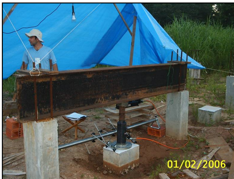
Figura 3. 10 – Montagem do sistema e realiza o da pr -carga
