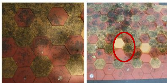
Figura 81 – Limpeza com uso de detergente e água morna – ladrilhos dos platôs. FONTE: autora, 2011.
