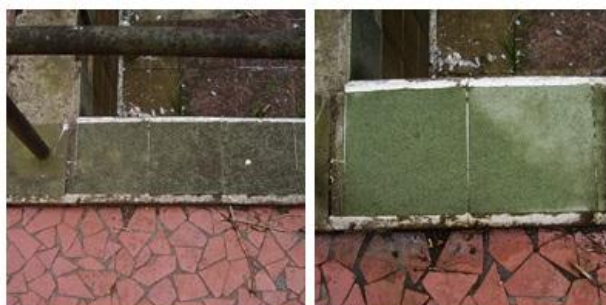
Figura 88 – Limpeza com uso de detergente e água morna – ladrilhos da piscina infantil. FONTE: autora, 2011.
