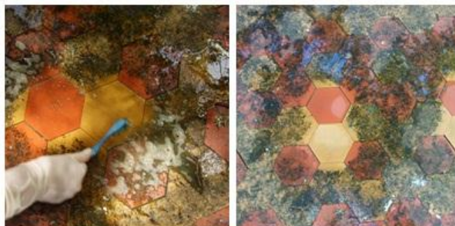
Figura 80 – Limpeza com uso de sabão e água morna – ladrilhos dos platôs. FONTE: autora, 2011.
