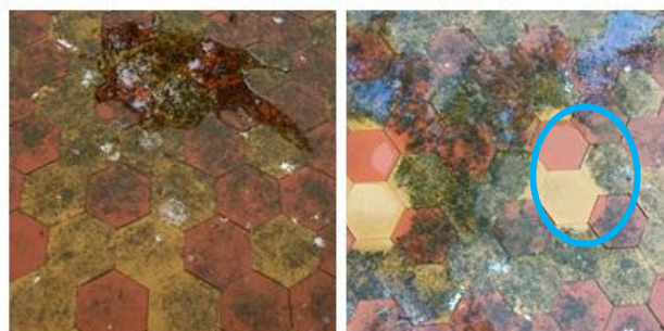
Figura 77 – Limpeza com uso de sabão e água fria – ladrilhos dos platôs. FONTE: autora, 2011.
