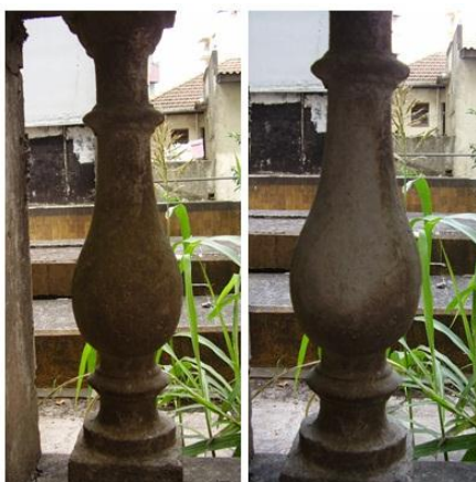
Figura 71 – Limpeza com uso de detergente e água fria - balaústres. FONTE: autora, 2011.
