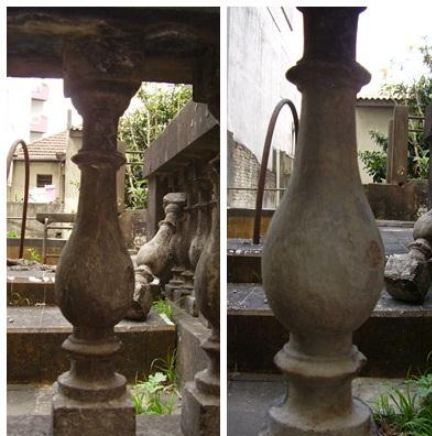
Figura 75 – Limpeza com uso de água sanitária e água morna - balaústres. FONTE: autora, 2011.
