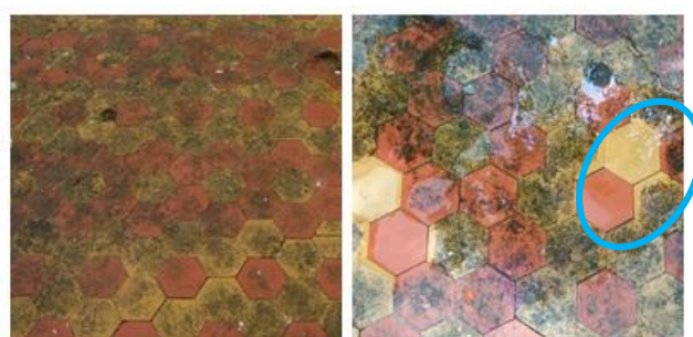
Figura 79 – Limpeza com uso de água sanitária e água fria – ladrilhos dos platôs. FONTE: autora, 2011.
