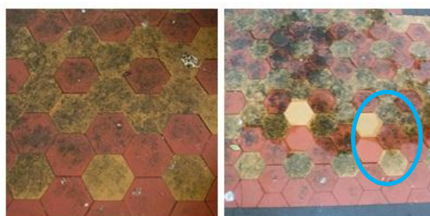
Figura 78 – Limpeza com uso de detergente e água fria ladrilhos dos platôs. FONTE: autora, 2011.
