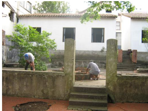
Figura 33 – Estado do jardim após a limpeza- operários reconstruindo canteiros. FONTE: acervo do Museu Educativo Gama d’Eça e Victor Bersani, 1998.
