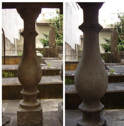
Figura 73 – Limpeza com uso de sabão e água morna - balaústres. FONTE: autora, 2011.
