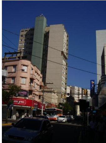
Figura 04 - Vista da Rua do Acampamento- observa-se o corredor de ônibus existente e ao fundo, o Edifício Taperinha.
