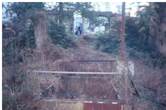
Figura 30 – Estado do jardim antes da limpeza- piscina infantil. FONTE: acervo do Museu Educativo Gama d’Eça e Victor Bersani, 1998.
