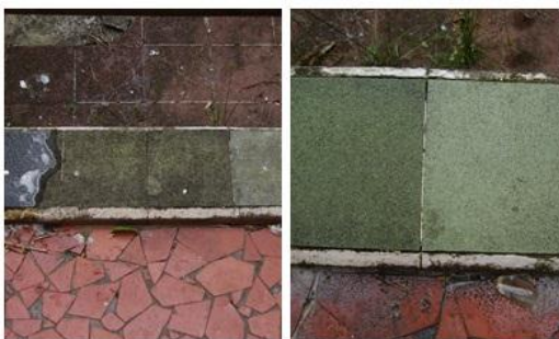
Figura 87 – Limpeza com uso de sabão e água morna – ladrilhos da piscina infantil. FONTE: autora, 2011.
