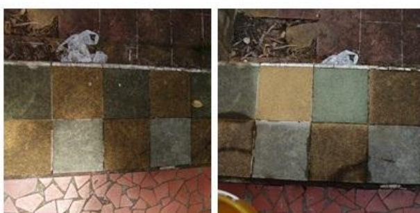
Figura 85 – Limpeza com uso de detergente e água fria – ladrilhos da piscina infantil. FONTE: autora, 2011.
