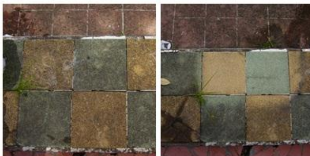
Figura 84 – Limpeza com uso de sabão e água fria – ladrilhos da piscina infantil. FONTE: autora, 2011.
