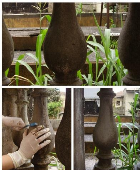
Figura 57 – Etapas do procedimento da limpeza - molhagem, aplicação do produto e enxágue. Limpeza dos balaustres.
