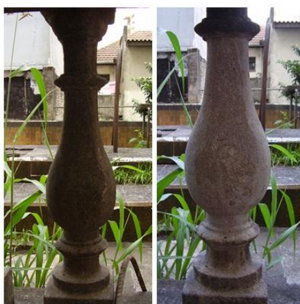
Figura 72 – Limpeza com uso de água sanitária e água fria - balaústres. FONTE: autora, 2011.
