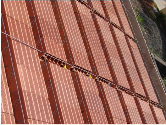
a) Nervura transversal entre lajotas cerâmicas.
