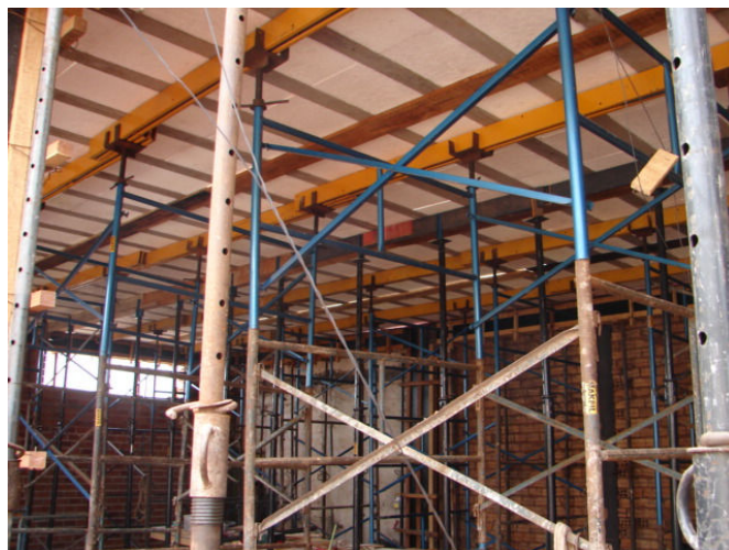
Figura 2.2 - Sistema de escoramento em lajes pré-moldadas treliçadas. Fonte: Figueiredo Filho e Shiramizu (2011).
