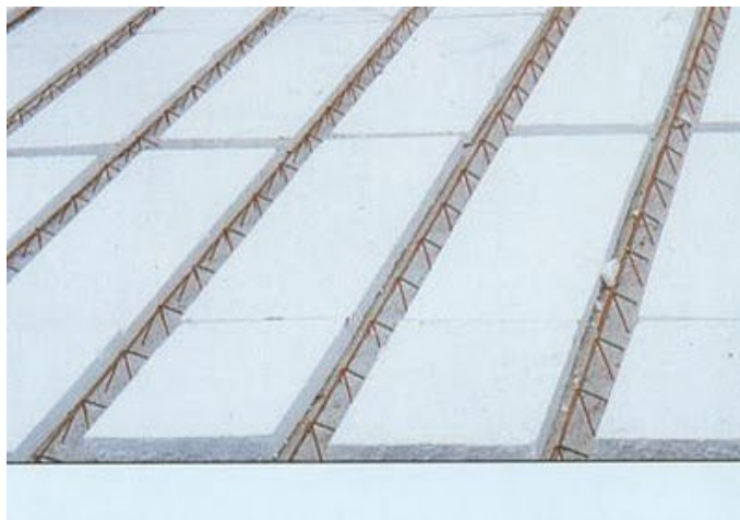
Figura 3.7 - Laje com vigotas treliçadas. Fonte: (www.premolbicas.wix.com)
