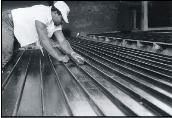
Figura 2.6 - Aplicação do desmoldante em fôrmas devidamente posicionadas, limpas e secas. Fonte: PUMA (2002).
