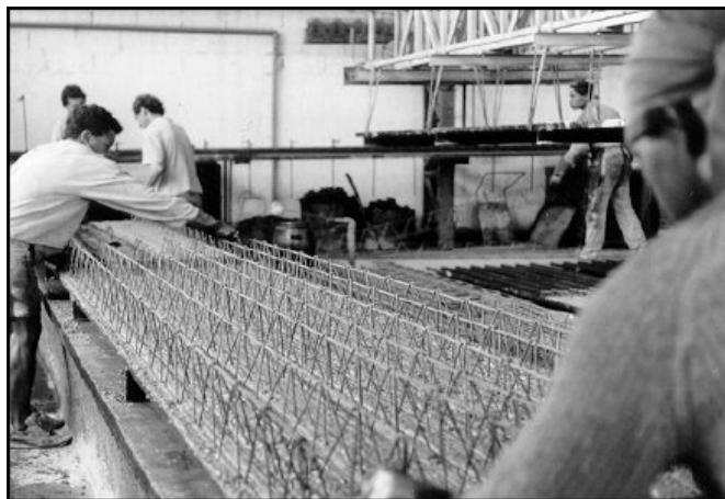
Figura 2.8 - Posicionamento da treliça metálica no concreto Fonte: PUMA (2002).
