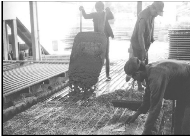
Figura 2.7 - Lançamento e nivelamento do concreto sobre as fôrmas. Fonte: PUMA (2002).
