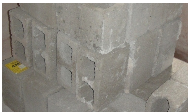
Figura 17 - Bloco estrutural de concreto utilizado na obra analisada.
