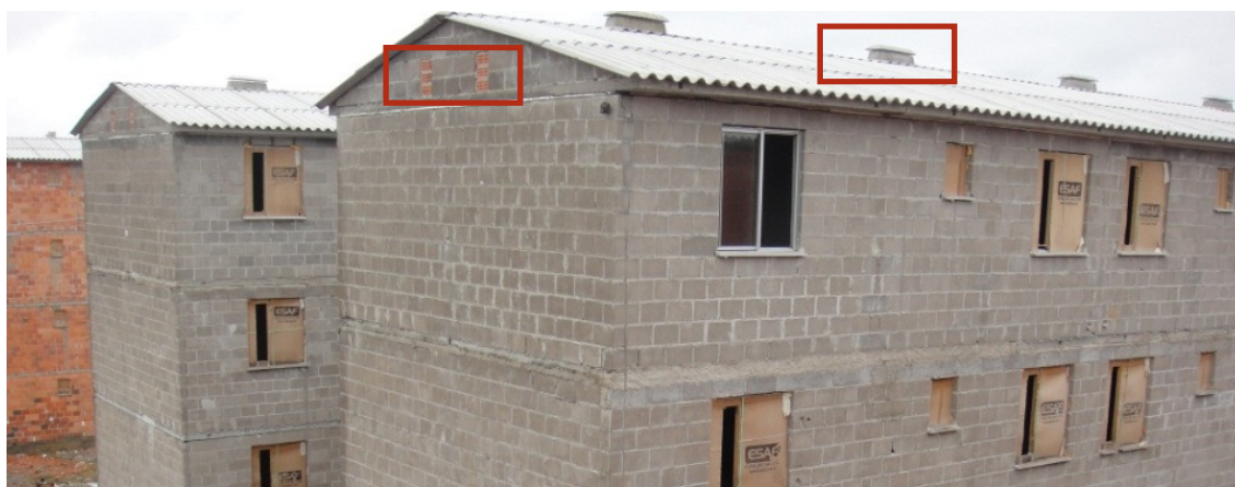
Figura 11 - Detalhe das aberturas de ventilação e também dos blocos para ventilação no oitão.
