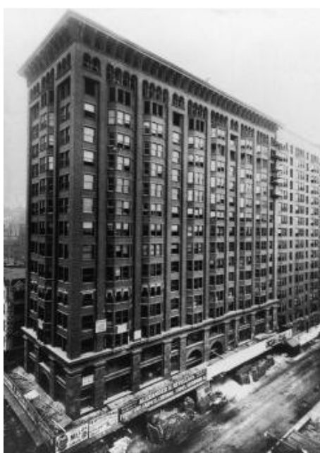
Figura 5 - Edifício Monadnock, Chicago. Fonte: http://www.monadnockbuilding.com/history.htm (2011)
