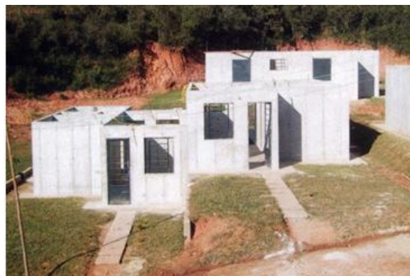
Figura 2.18 – Casa concreto celular (Fonte: TÉCHNE, 89/2004).
