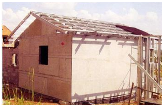
Figura 2.22 – Casa com placas de concreto (Fonte: TÉCHNE, 79/2003).
