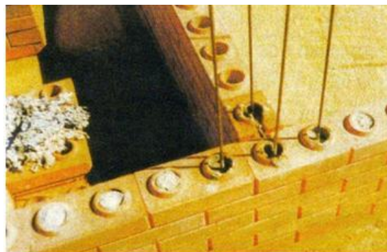
Figura 2.26 – Detalhe tijolo de solo-cimento (Fonte: TÉCHNE, 85/2004).
