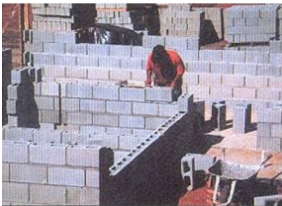
Figura 2.15 – Casa com bloco de concreto.
