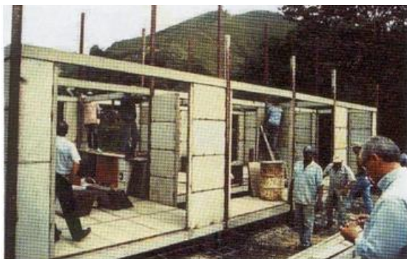
Figura 2.21 – Detalhe das placas de concreto (Fonte: IPT, 1998).
