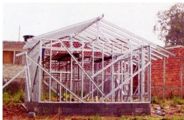
Figura 2.9 – Vista frontal casa de aço. (Fonte: TÉCHNE, 79/2003).
