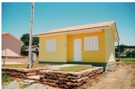
Figura 2.10 – Casa de 45,11 m 2 (2 dormitórios)
