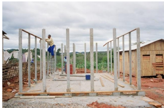
Figura 3.16 – Cintamento no topo dos pilares.
