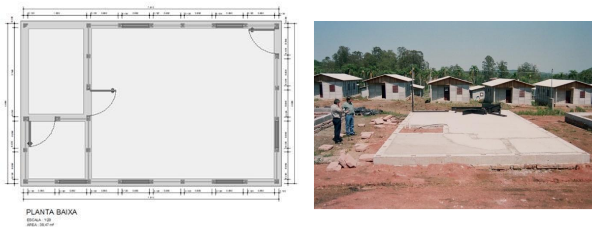
Figura 3.13 – Vista superior do contrapiso executado.
