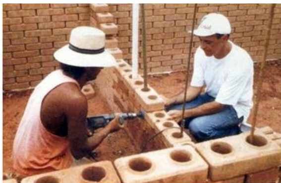
Figura 2.25 – Montagem da casa de solo-cimento (Fonte: TÉCHNE, 85/2004).
