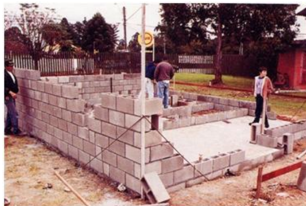
Figura 2.16 – Técnica com bloco de concreto.
