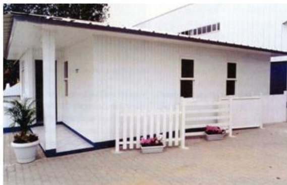
Figura 2.23 - Casa de PVC da MEDABIL (Fonte: TÉCHNE, 79/2003).
