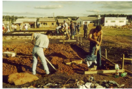
Figura 3.7 – Execução da vala de fundação
