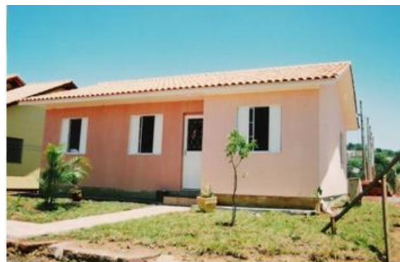
Figura 2.13 – Casa de 66,75 m 2 (4 dormitórios)
