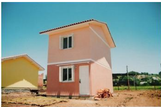
Figura 2.12 – Casa de 46,57 m 2 (2 dormitórios)
