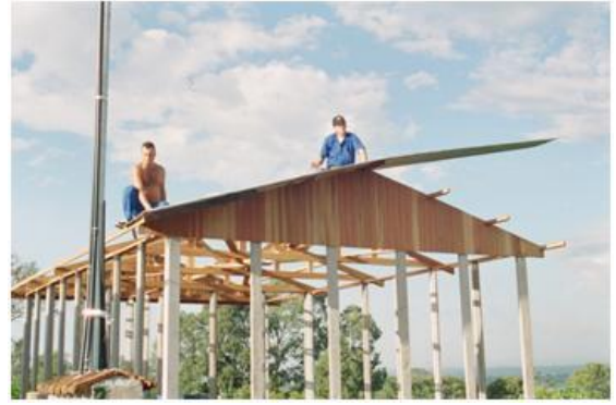
Figura 3.19 – Colocação das telhas.
