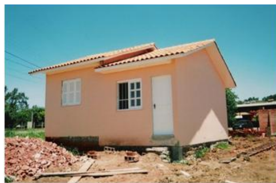
Figura 2.11 – Casa de 46,50 m 2 (2 dormitórios)
