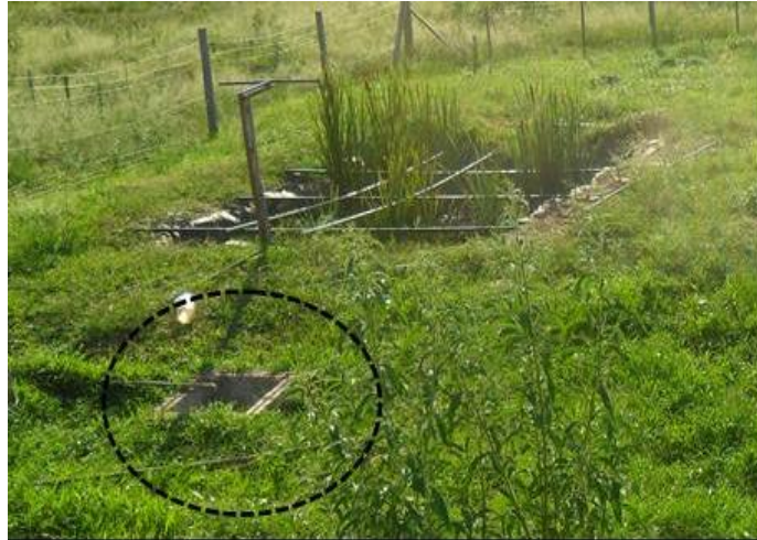
Figura 27 – Caixa de medição de vazão do afluente do FPMV.
