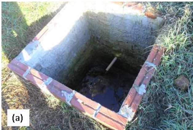
Figura 25 - Destino do efluente após percolação pelo FPMV. a) caixa de inspeção do FPMV; b) vala de infiltração.
