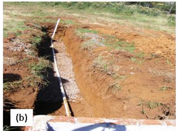
Figura 25 - Destino do efluente após percolação pelo FPMV. a) caixa de inspeção do FPMV; b) vala de infiltração.
