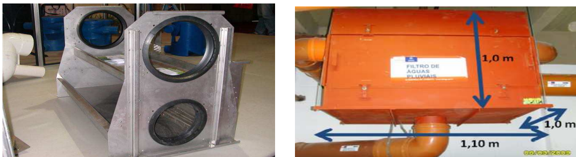
Figura 2.9 – Filtro VF6 para até 1.500 m 2 de telhado e instalado em caixa metálica.
