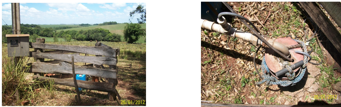
Figura 31- Poço P09 (Localidade de Beira Rio). Cota altimétrica de 286,00m, SASG.
