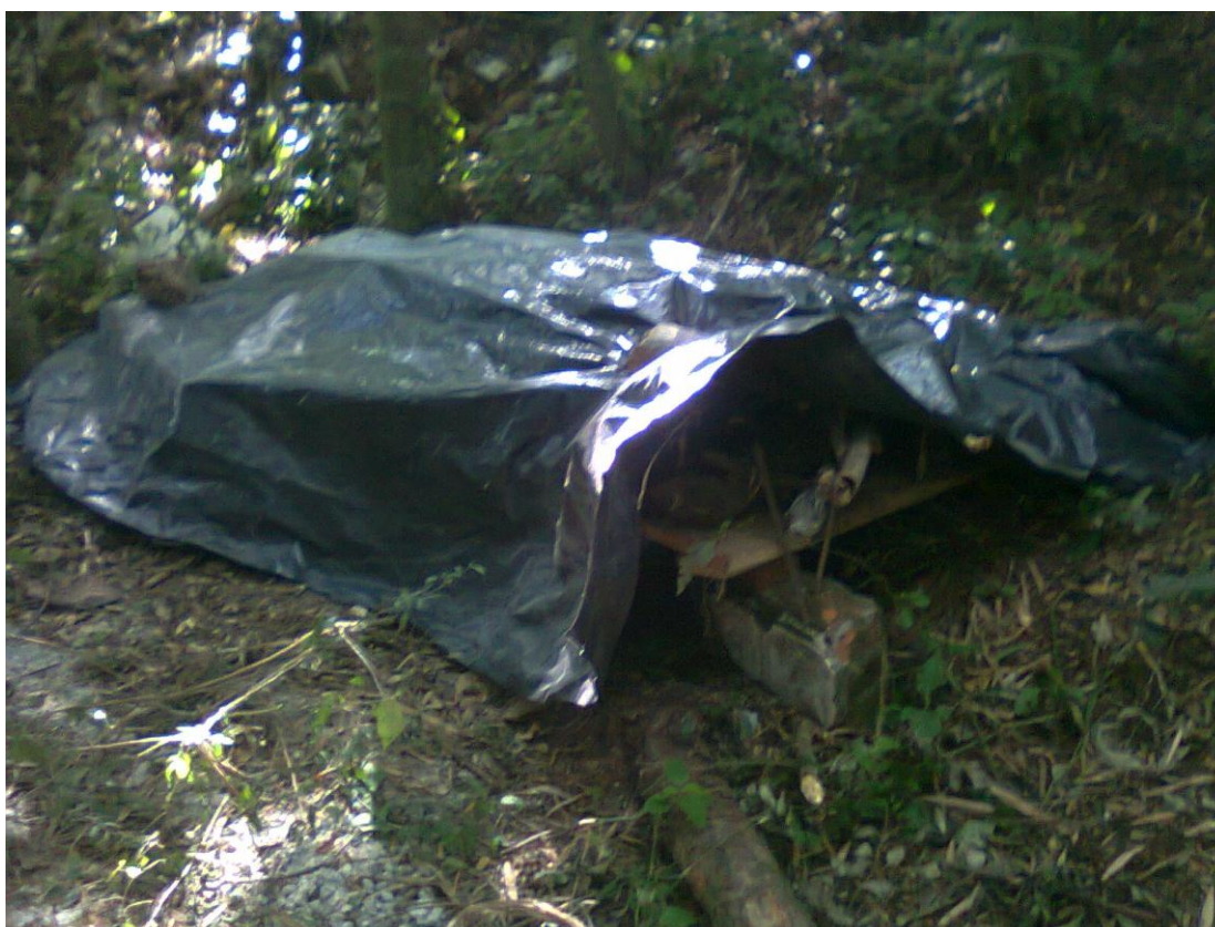
Figura 17 – Lona para proteção dos resíduos sólidos
