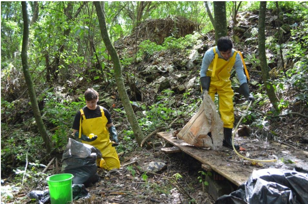
Figura 16 – Piso para disposição e escoamento do excesso de umidade dos resíduos sólidos coletados
