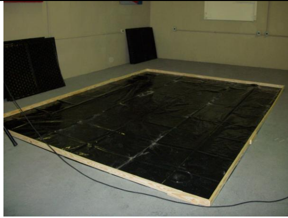
1° Colocação de membrana de proteção antirraízes
