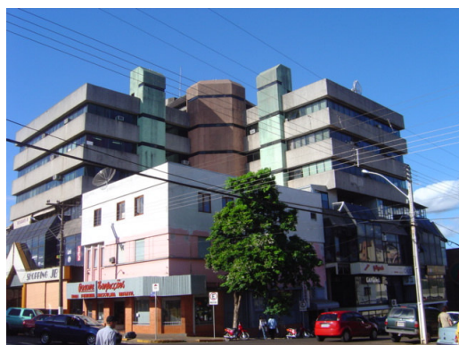
vista da fachada 01 e 02
