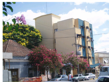
vista da fachada 04 e entorno imediato
