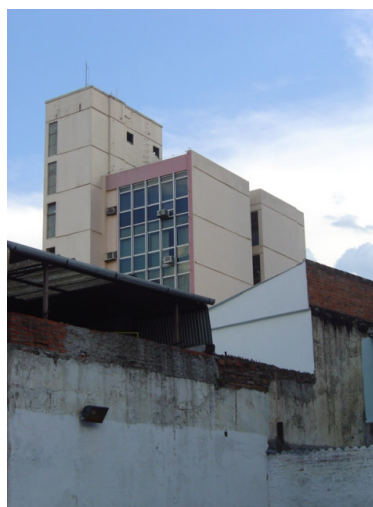
vista da fachada 03
