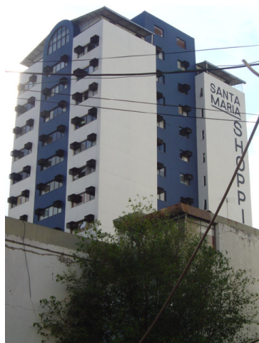
vista da fachada 03 e 04
