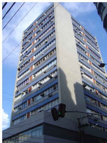
vista da fachada 01 e 02
