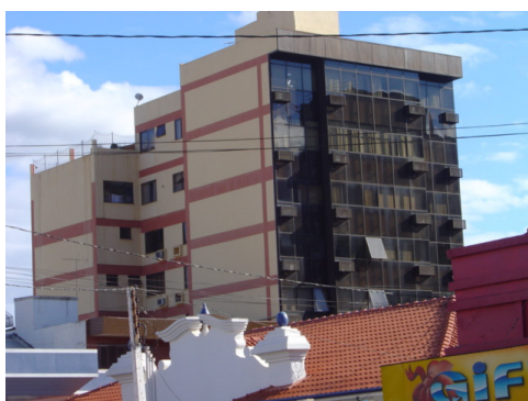
vista da fachada 01 e 04
