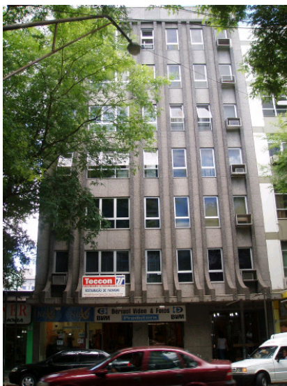
vista da fachada principal
