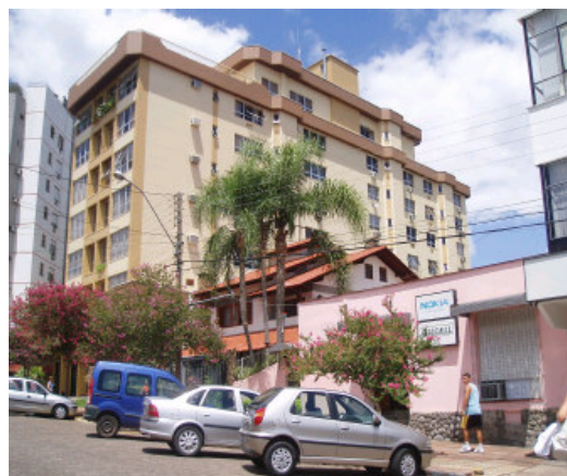
vista da fachada 02, sendo a 04 igual
