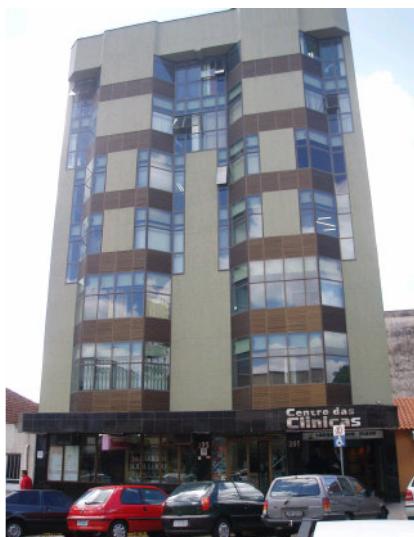
vista da fachada 01
