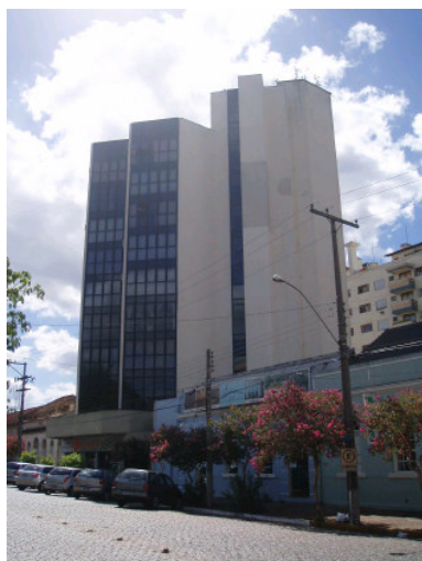
vista da fachada 02 e entorno imediato
