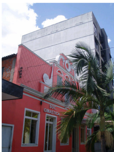
vista da fachada 04
