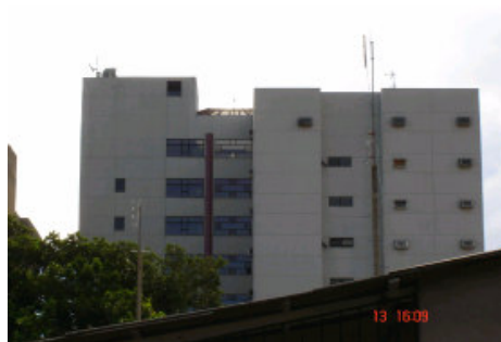
vista da fachada 03
