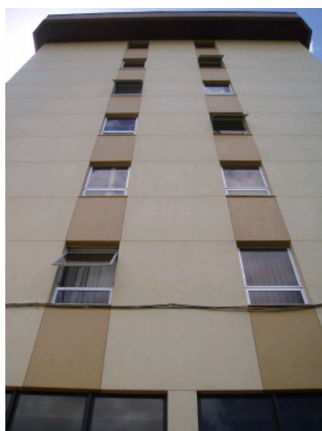
vista da fachada 03 parte superior
