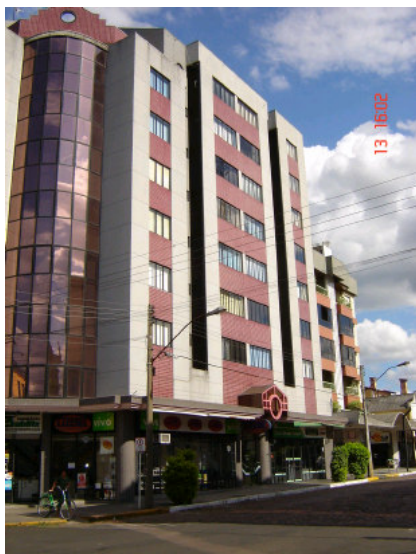
vista da fachada 01
