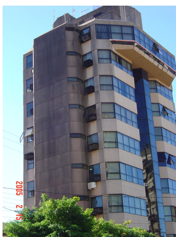
vista da fachada 01 e 04
