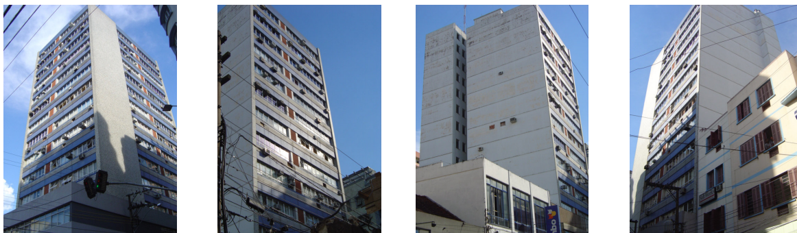
Figura 16 - Levantamento fotográfico das fachadas do prédio escolhido da tipologia B
