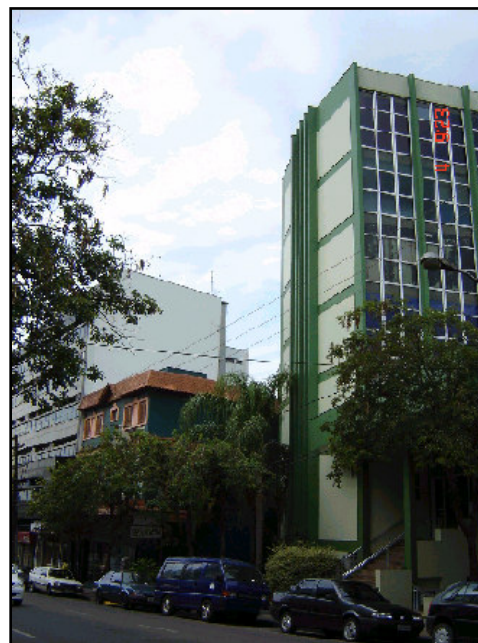
vista da fachada 04
