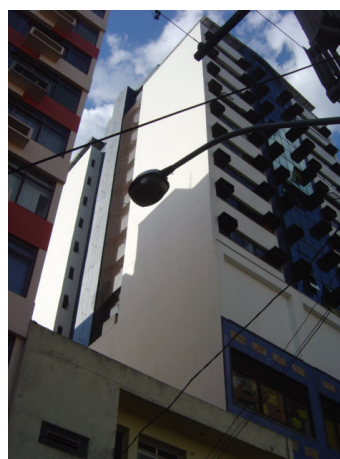
vista da fachada 04 e 01
