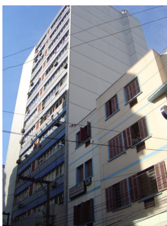
vista da fachada 02 e 03
