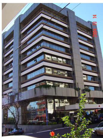
vista esquina (fachada 01/02)
