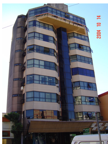
vista da fachada 01
