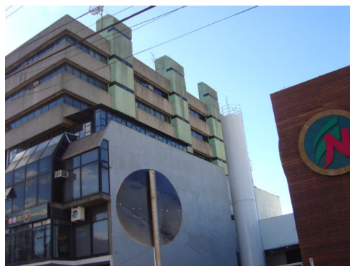
vista da fachada 03
