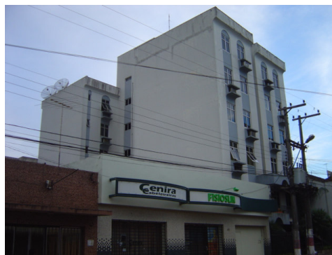
vista da fachada 02
