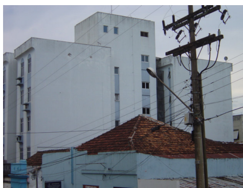
vista da fachada 03
