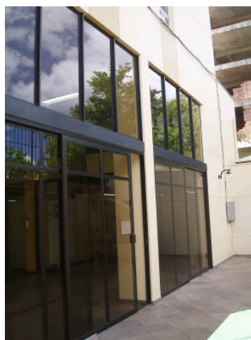
vista da fachada 03 parte inferior
