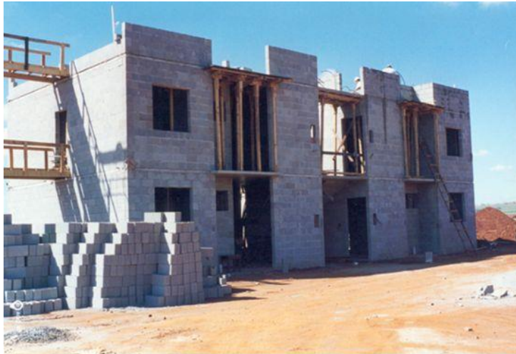
Figura 2.2 – Edifício de alvenaria estrutural. Fonte: www.pedreiro.com.br
