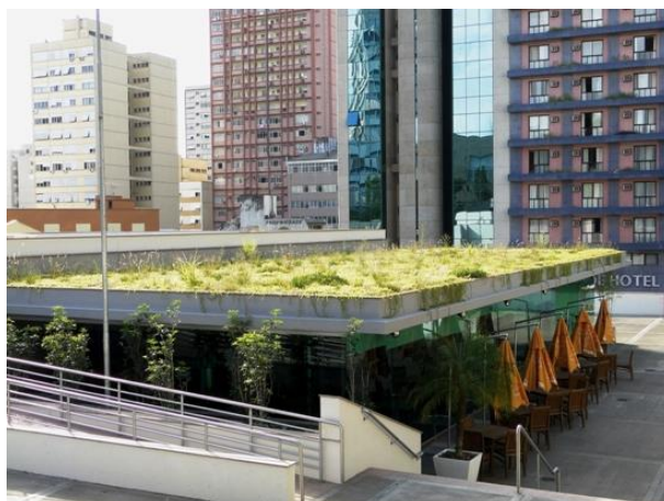
Figura 1 - Exemplo de um telhado verde.
