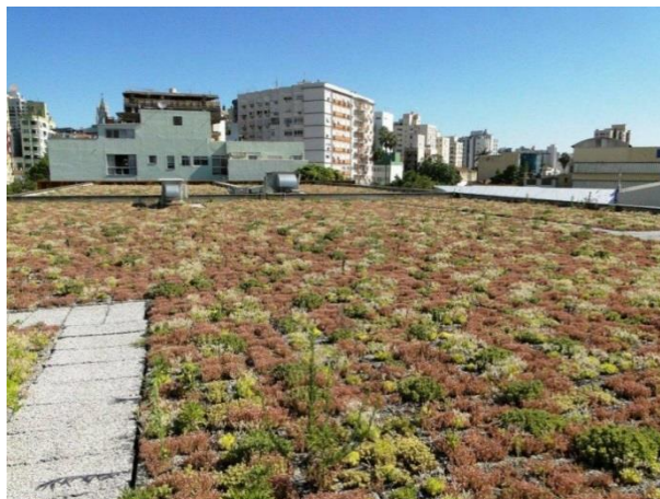
Figura 4 - Telhado verde extensivo em um prédio da Gerdau.
