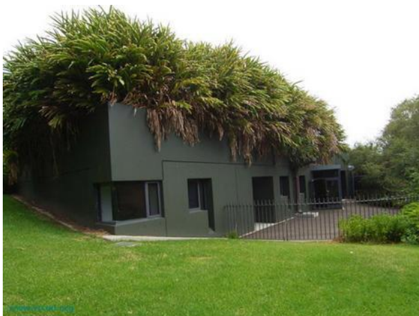
Figura 6 - Telhado verde intensivo no Sydney Conservatorium of Music.
