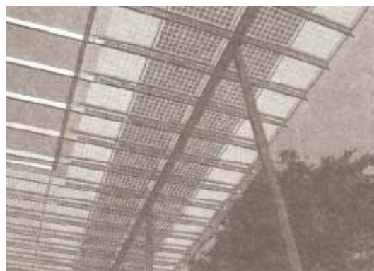
Figura 8 – Marquise com os sistemas fotovoltaicos integrados. Fonte: KEELER; BURKE (2009, p. 302).
