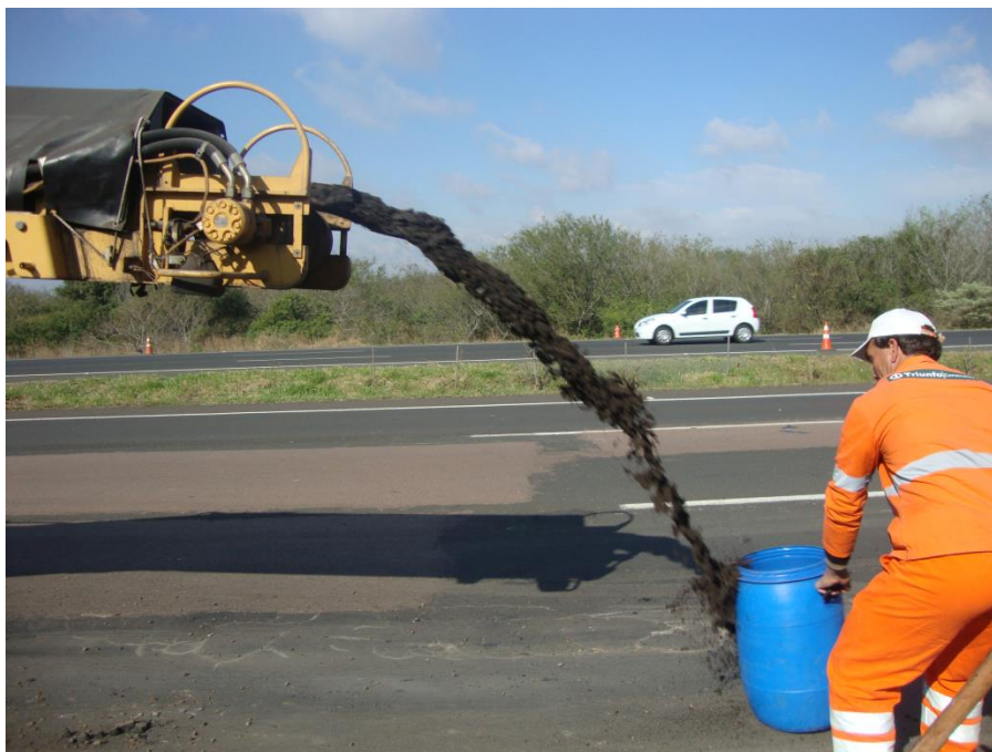
Figura 39 – Coleta de amostra diretamente da fresadora
