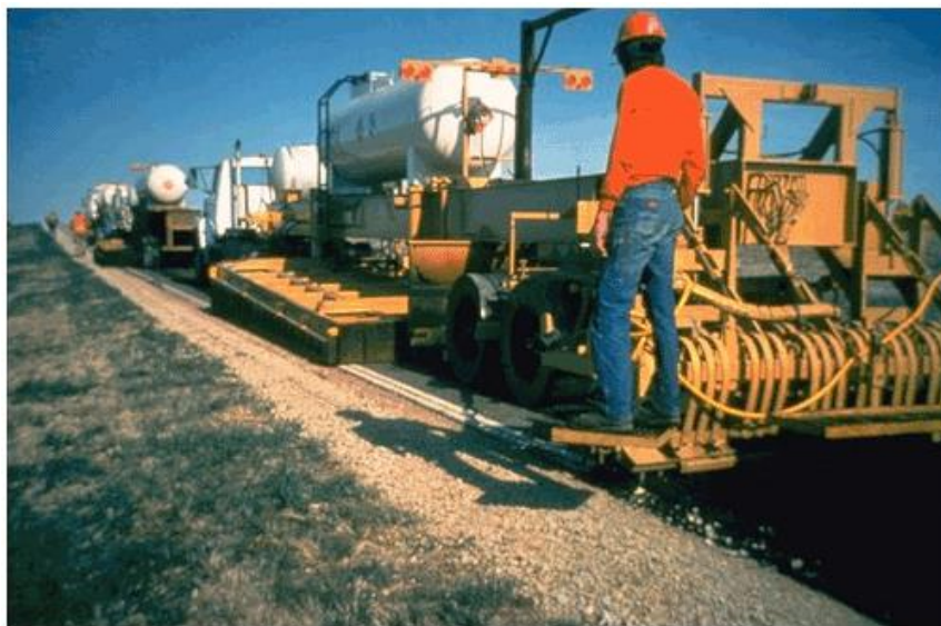
Figura 21 – Processo de reciclagem de superfície
