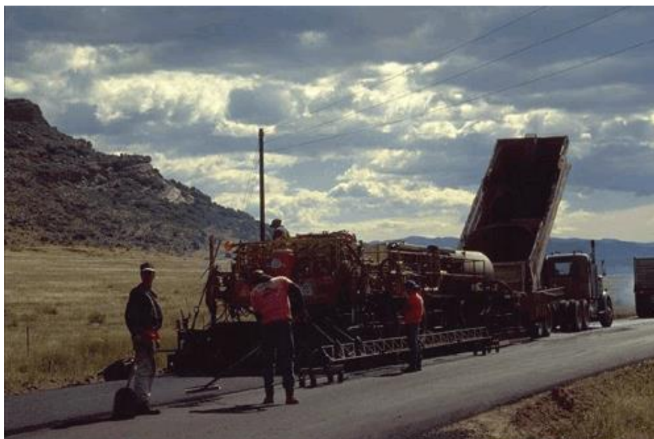
Figura 24 – Processo de repavimentação
