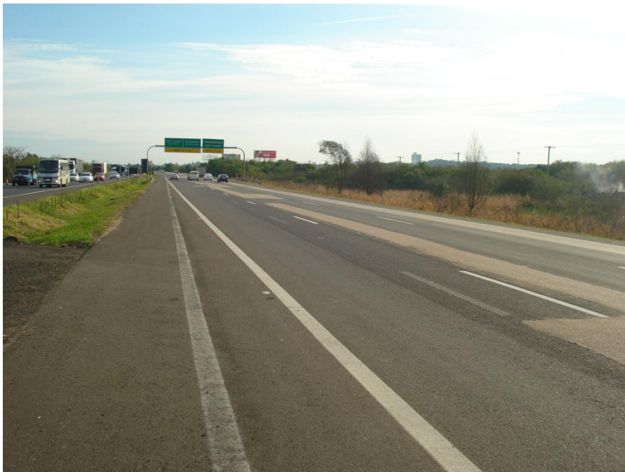
Figura 38 – Vista do trecho que foi feita a fresagem
