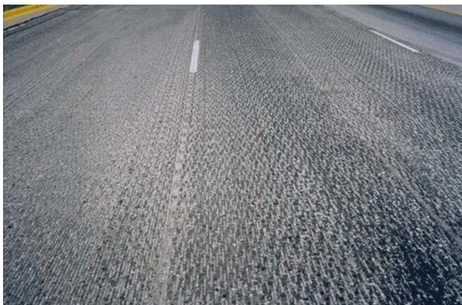
Figura 5 – Superfície resultante de fresagem a frio
