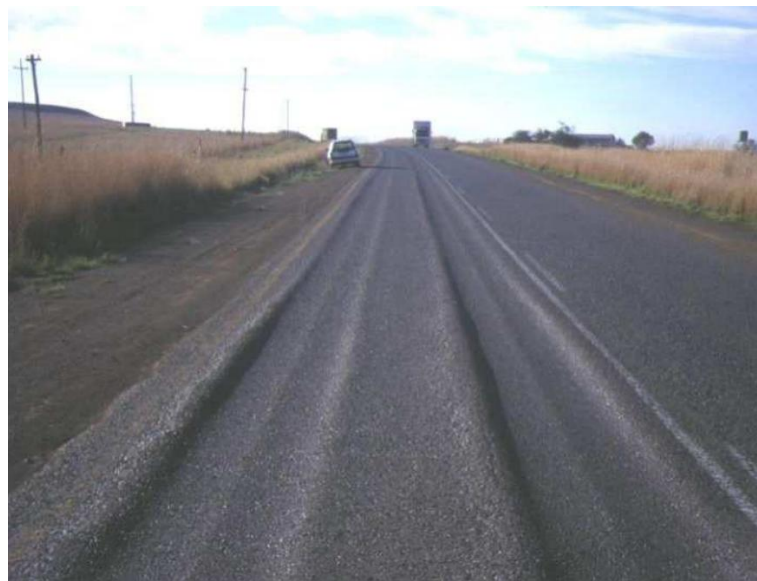
Figura 24 - Deformação permanente na trilha de roda
