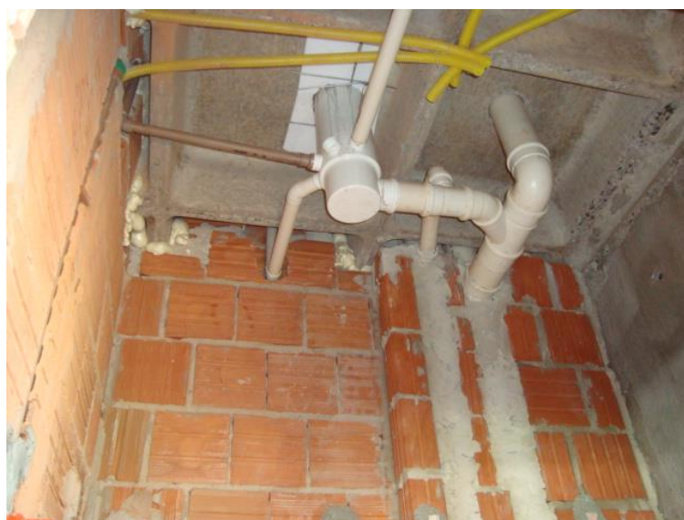
Figura 2.11 – Instalação de esgoto sanitário sob uma laje nervurada.
