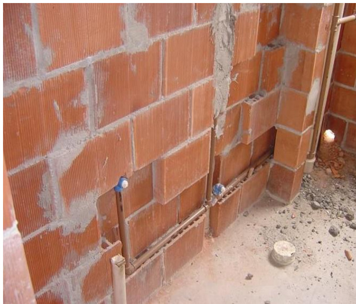
Figura 2.13 – Parede hidráulica com tubulação de água fria.
