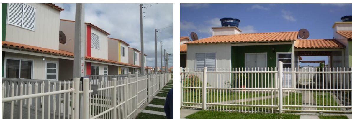
(a) (b) Figura 53 – (a) sobrados do conjunto; (b) casas térreas.
