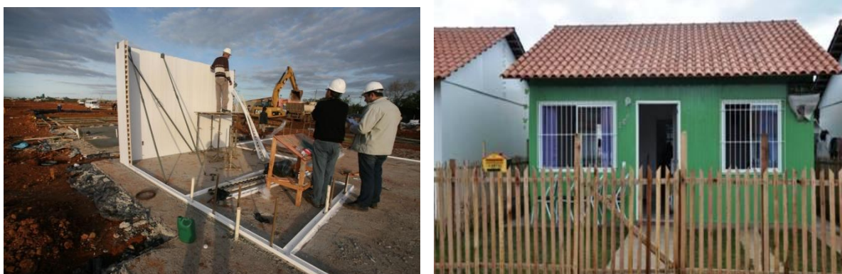
(a) (b) Figura i – (a) fase de construção; (b) colocação de grades
