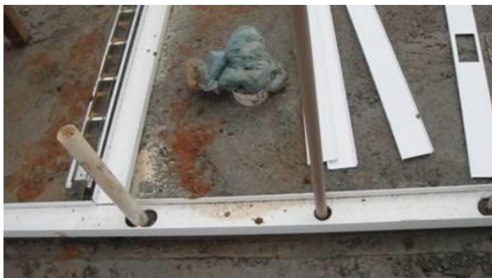
Figura 32 – Passagem dos tubos pela canaleta base.
