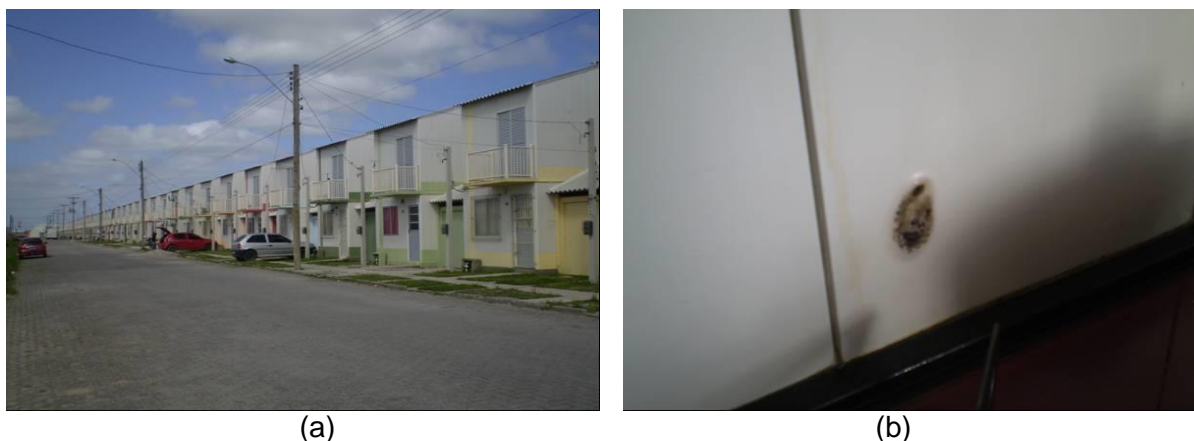
Figura 56 – (a) casa amarela com grades nas aberturas; (b) marca ocasionada por perfil incendiado.
