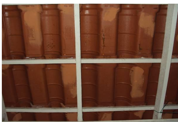
Figura xvii – (a) condensação na telha; (b) edificação em construção.
