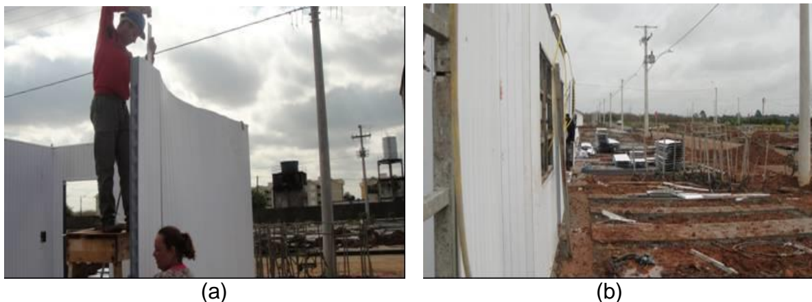
Figura 28 – Montagem dos perfis: (a) encaixe com auxílio do martelo; (b) ao fundo no chão, perfis previamente encaixados em blocos.
