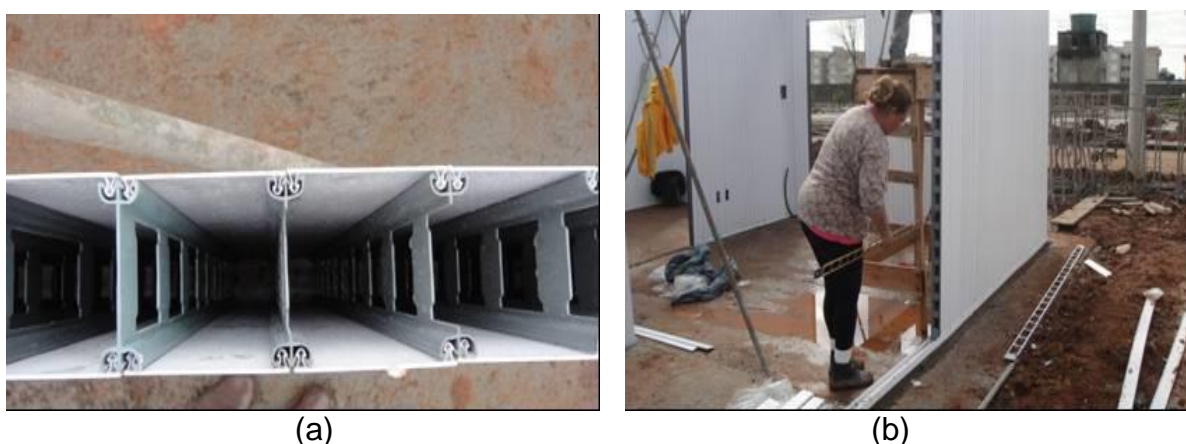
Figura 29 – Perfis: (a) encaixe dos módulos de PVC; (b) posicionamento dos reforços metálicos verticais
