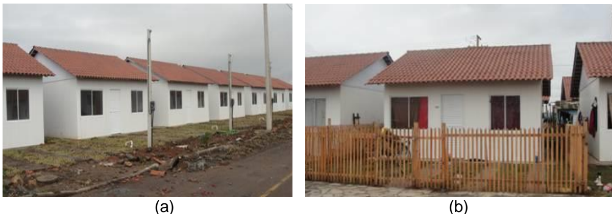
Figura 25 – Habitações finalizadas: (a) unidade em fase de limpeza para entrega; (b) casa habitada pertencente à primeira fase de entrega.
