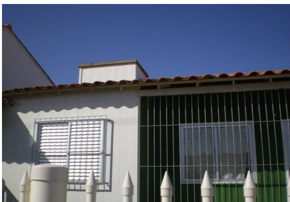
Figura xvi – (a) grades nas aberturas; (b) esquadria de madeira.
