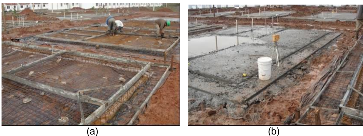
Figura 26 – Radier: (a) utilização dos gabaritos metálicos; (b) marcação de nível.
