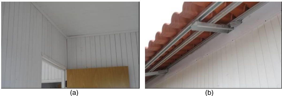
Figura 39 – Acabamentos: (a) parte externa, passarinheira; (b) forro interno em PVC.
