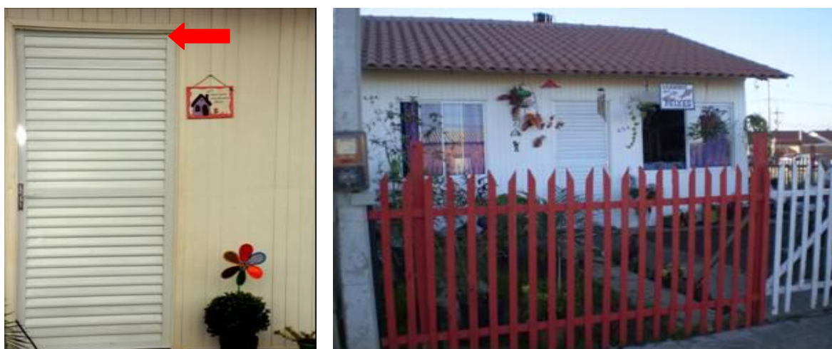
(a) (b) Figura ii – (a) deformação observada nos marcos da porta; (b) imagem da casa ocupada.
