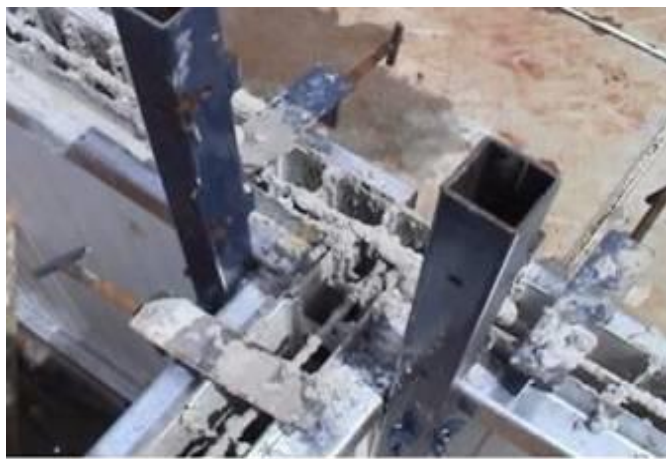
Figura 5 – Elementos para ajuste das paredes. Fonte: SOUZA 2005.
