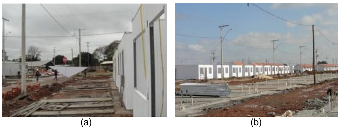
Figura 24 – Etapas da construção: (a) finalização das paredes e transporte do oitão; (b) várias fases da fundação à cobertura.
