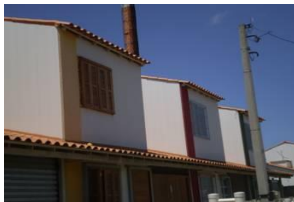
Figura xvi – (a) grades nas aberturas; (b) esquadria de madeira.
