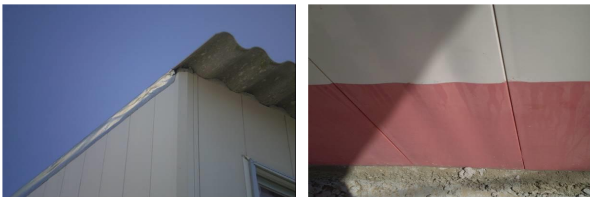
(a) (b) Figura 57 – (a) colocação de manta na cobertura; (b) manchas na coloração do PVC.
