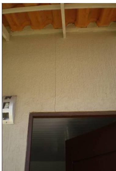
Figura xviii – (a) trinca na textura; (b) lareira implantada; (b) manta colocada na cobertura.
