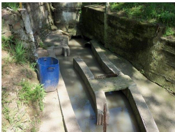
Não é um sistema adequado às vazões nem à eficiência desejada e a limpeza manual não é facilitada por formatos de grade e espaçamentos entre as barras, que facilitem essa limpeza.
