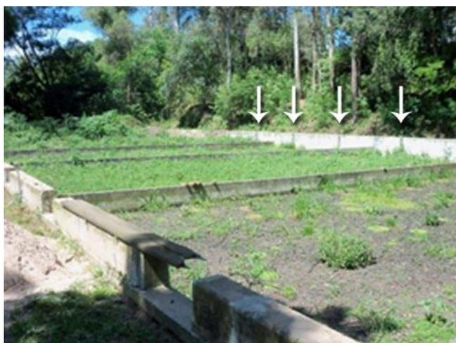
A presença de vegetação desenvolvida nos leitos de secagem era indicadora de longos períodos de detenção dos lodos, o que sugere que não tinham sido removidos com a frequência necessária estabelecida em projeto.
