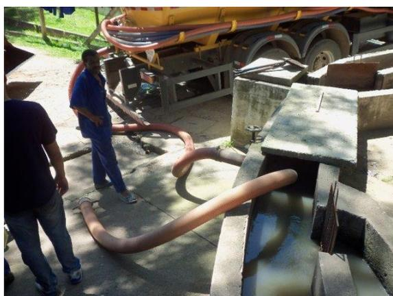
Figura 17 - Descarga dos caminhões de coleta dos efluentes de tanques sépticos no início do desarenador da ETE do Parque do Imhoff
