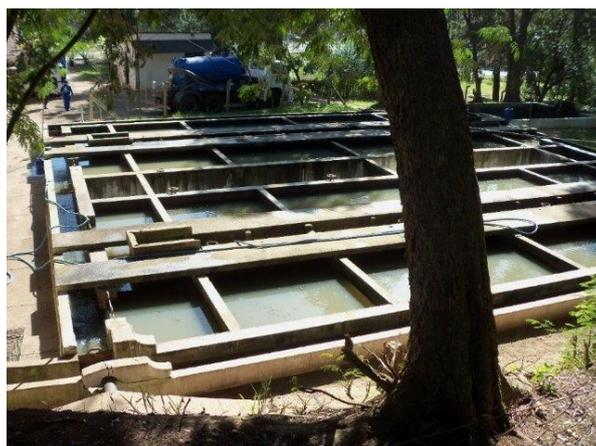
As “Câmaras Imhoff” possuem em sua periferia canais de circulação de efluentes onde o fluxo pode ser direcionado por comportas para que o esgoto ingresse nos decantadores ora por um ou por outro lado, de forma que o lodo fresco decantado fique distribuído de forma mais regular ao longo dos quatro digestores que compõe cada conjunto.
