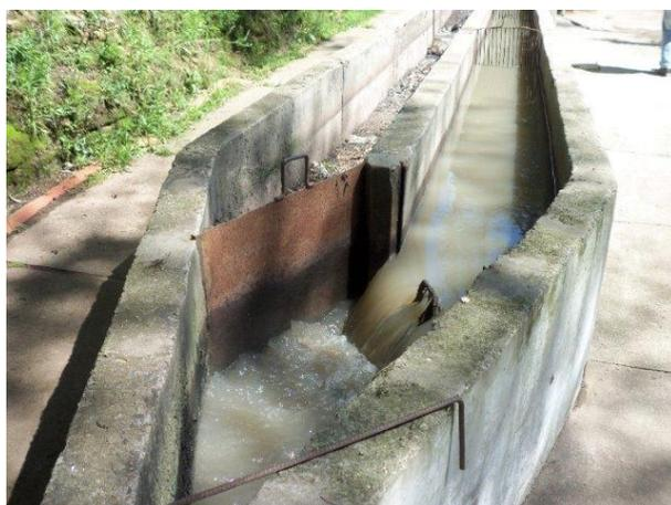
Não havia Manual de procedimentos para essa atividade, não eram registradas as quantidades de areia removida periodicamente e os resíduos removidos do desarenador eram dispostos em um dos espaços do Leito de Secagem de Lodos digeridos da ETE, ocupando uma das partições do leito de secagem, em detrimento da função original para a qual foi projetada.
