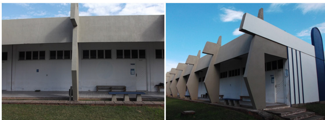
Figura 4.13-Imagens da Fachada Bloco C
