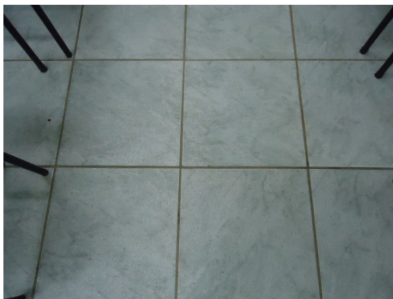
Figura 3.5- Piso cerâmico das salas de aula
