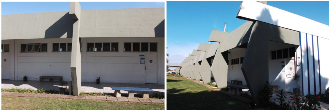
Figura 4.7- Imagens da fachada do Bloco E
