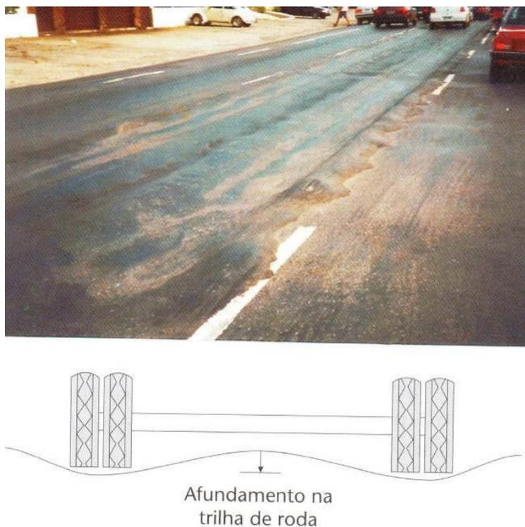
Figura 3.35: Exemplo de deformações em trilhas de roda de pavimento flexível
