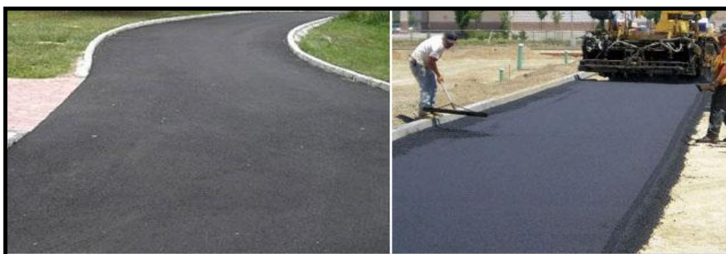
Figura 6 - Exemplo de mistura asfáltica usinada a quente do tipo AAUQ
