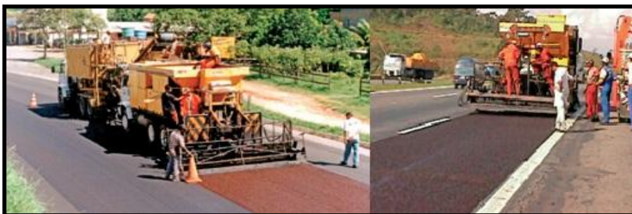
Figura 9 - Exemplo de mistura asfáltica a frio do tipo TSS/TSD
