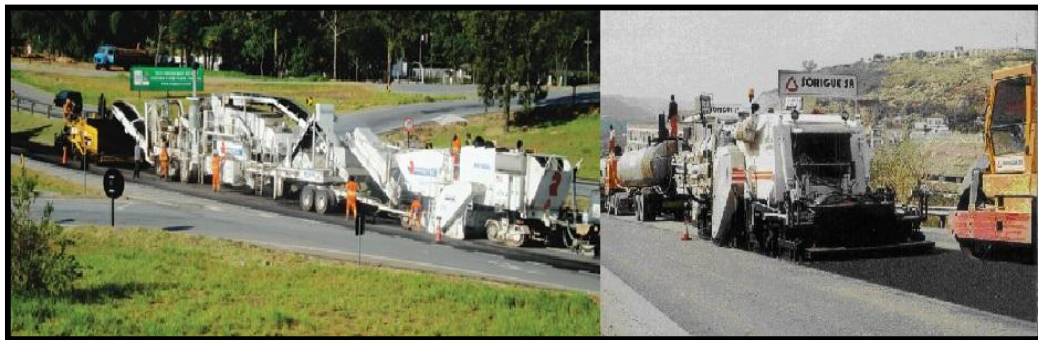
Figura 10 - Exemplo de mistura asfáltica a frio do tipo TSS/TSD
