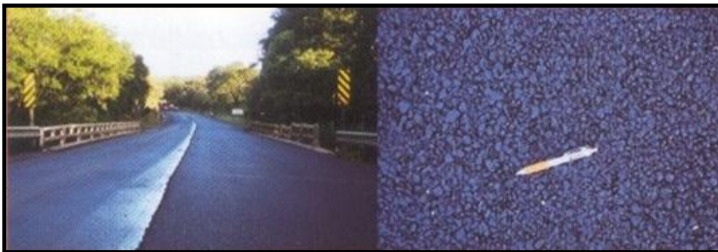
Figura 5 - Exemplo de mistura asfáltica usinada a quente do tipo Gap-graded
