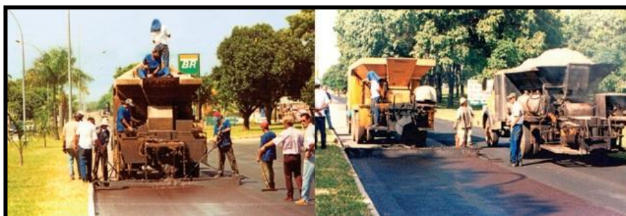
Figura 8 - Exemplo de mistura asfáltica a frio do tipo LA
