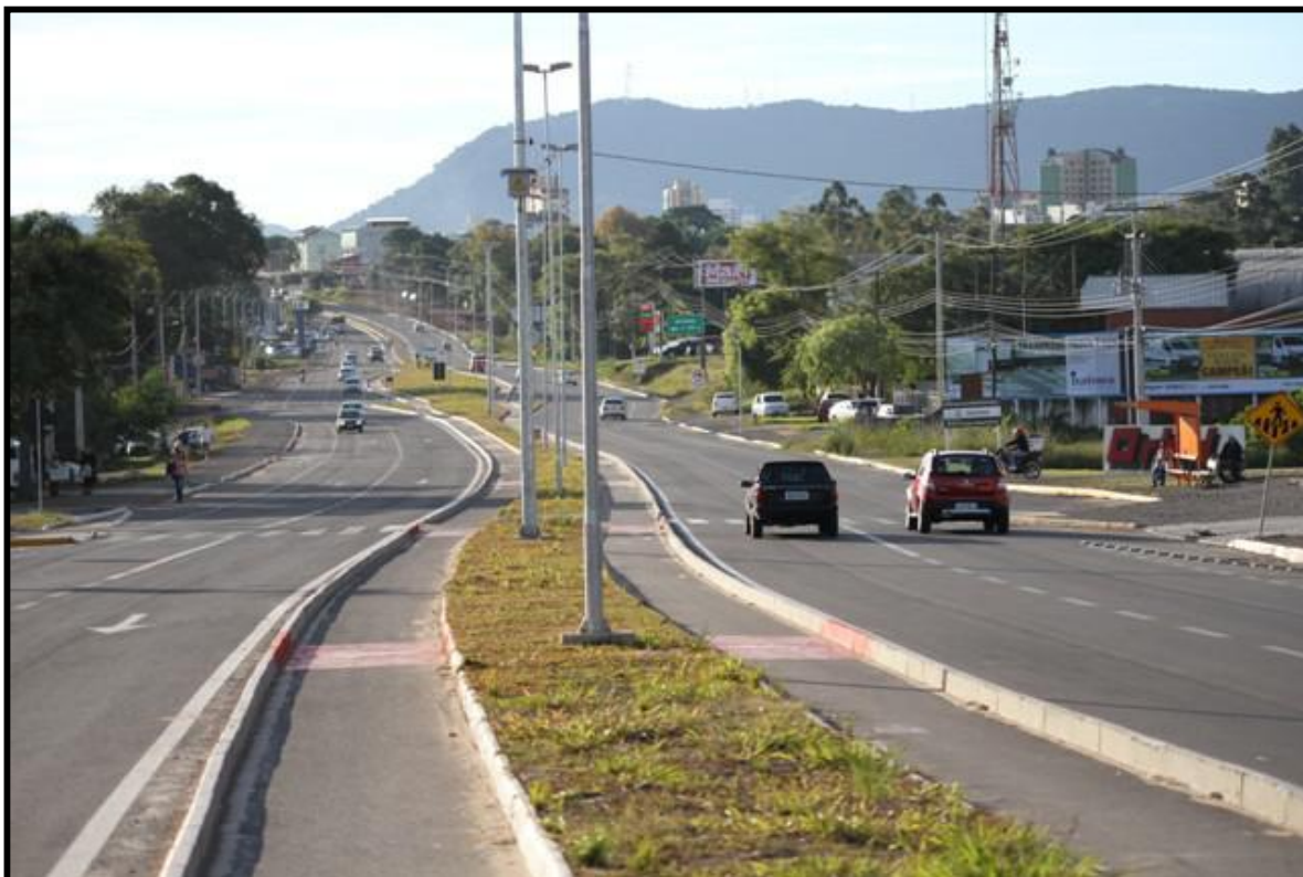
Figura 30 - Imagem do Trecho monitorado
