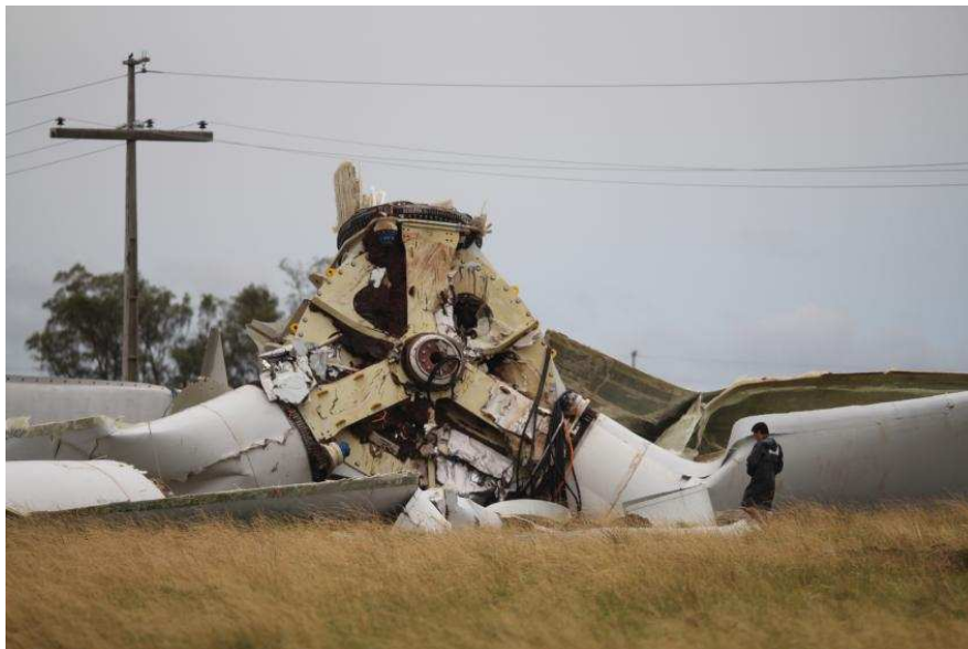
Figura: Torre do Parque eólico. Fonte: Marcelo Pinto – Jornal A Platéia (2014)
