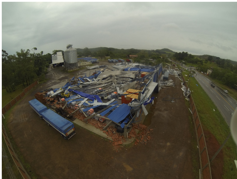
Figura: Cobertura de Galpão industrial. Fonte: Marcelo Pinto - Jornal A Platéia (2014)
