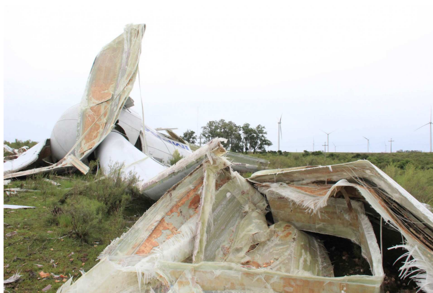
Figura: Torre do Parque eólico. Fonte: Daniel Badra – Agência RBS (2014)
