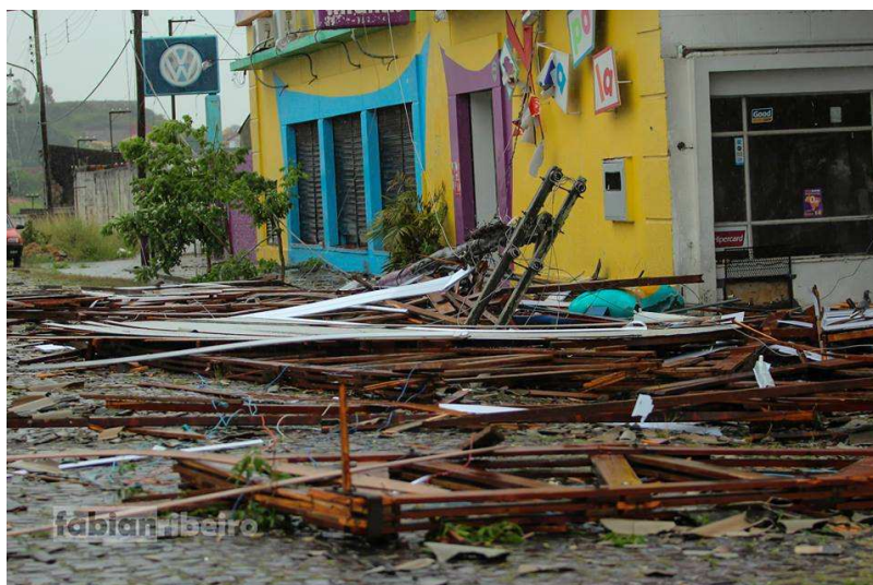
Figura: Parte da cobertura do prédio do Exército.
