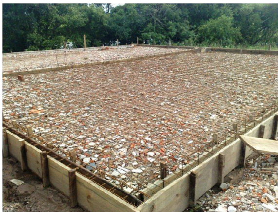
Figura 5 - RCD utilizado como sub-base.
