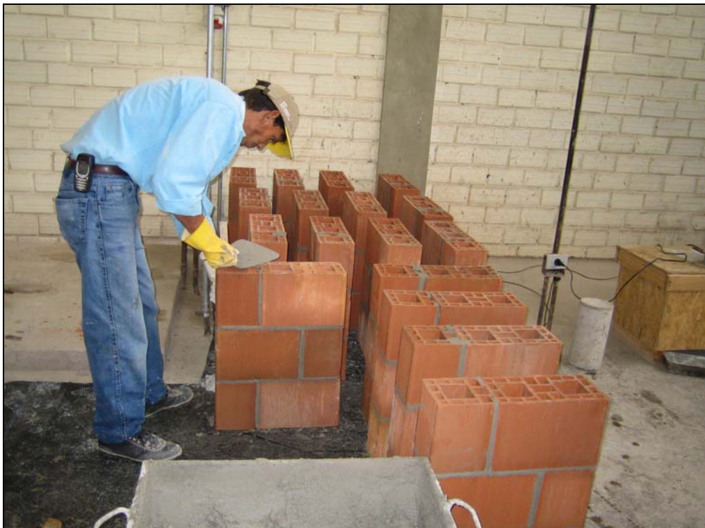
Figura 3.08 – Execução dos prismas.
