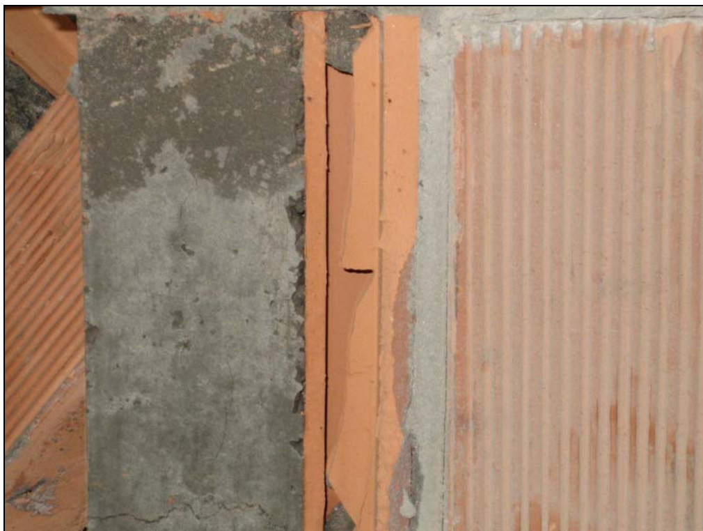
Figura 4.24 – Detalhe da interface bloco/graute.
