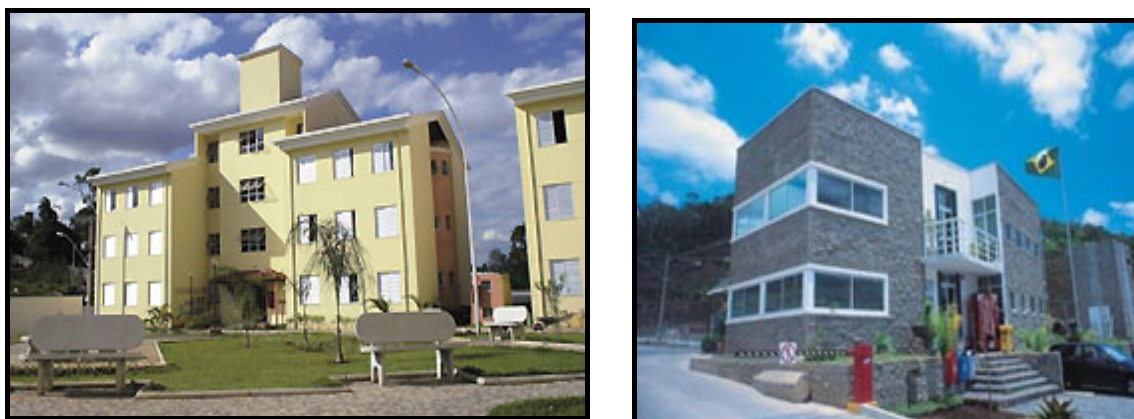
Figura 3 – Prédios de alvenaria estrutural abrangendo diferentes classes econômicas 4, 5 .
