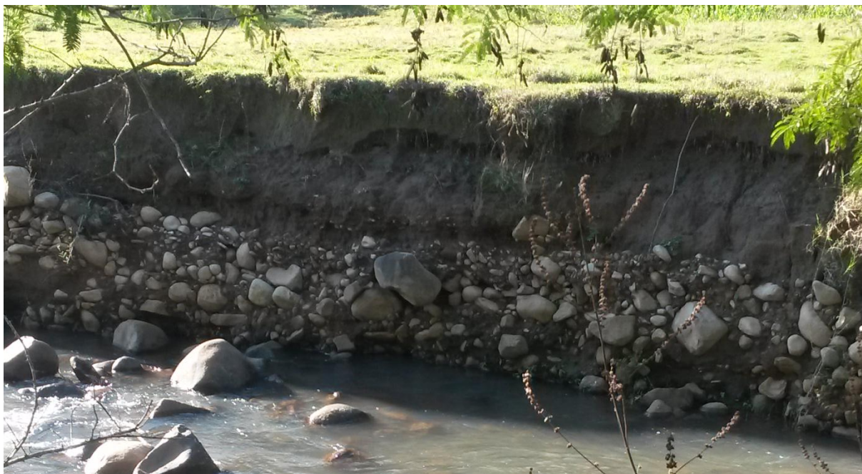
Figura 13 – Exemplo da estrutura e constituição das margens do trecho III do arroio Val de Buia.
